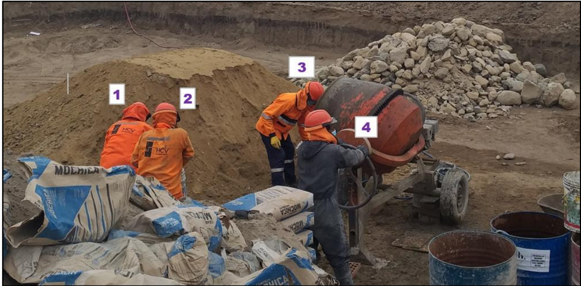
Ilustración 9: Cuadrilla O1 – O4 en concreto para sub cimiento
