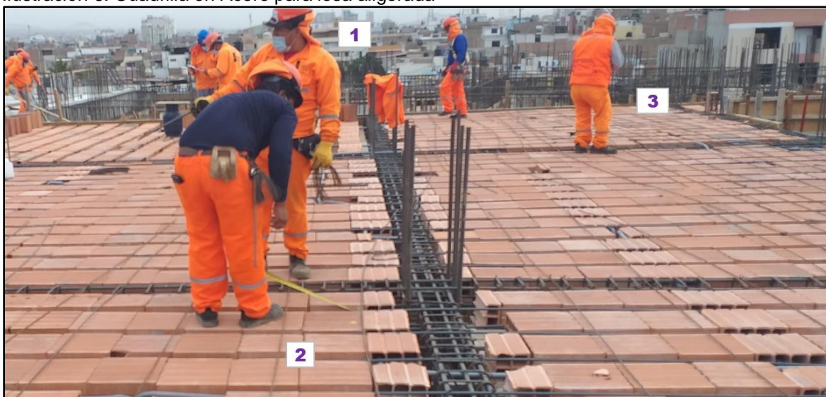
Ilustración 6: Cuadrilla en Acero para losa aligerada
