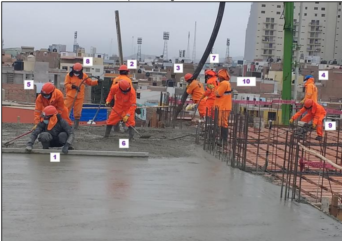
Ilustración 15: Cuadrilla en concreto para losa aligerada
