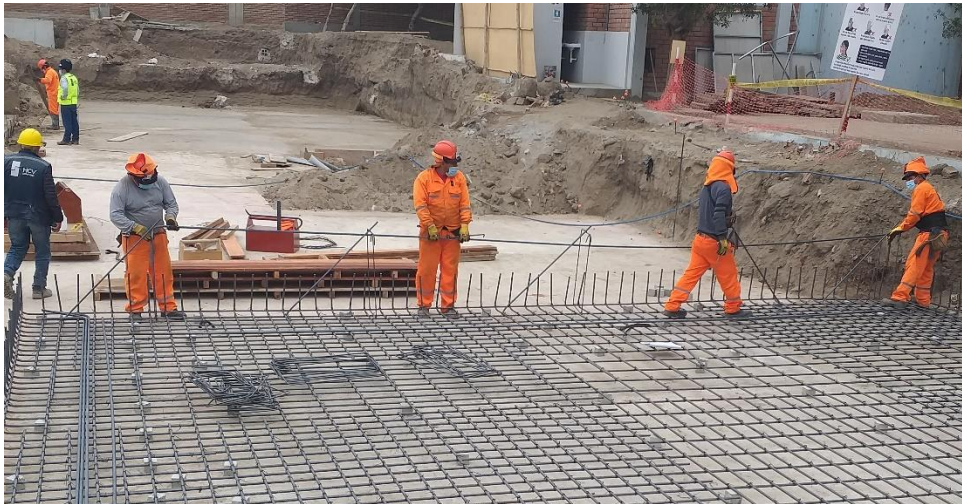
Foto N°26: Colocación de acero.
