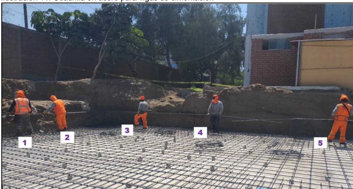
Ilustración 11: Cuadrilla en acero para vigas de cimentación
