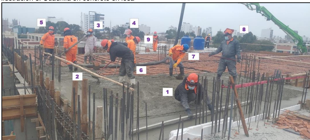
Ilustración 8: Cuadrilla en concreto en losa
