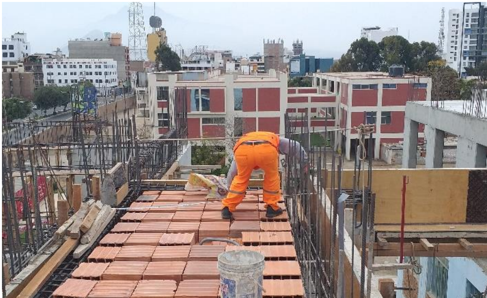
Foto N°4: Medición para Acero.
