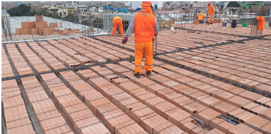
Foto N°2: Colocación de Acero.
