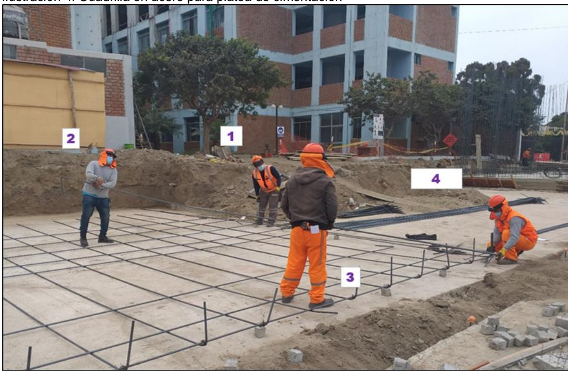
Ilustración 4: Cuadrilla en acero para platea de cimentación
