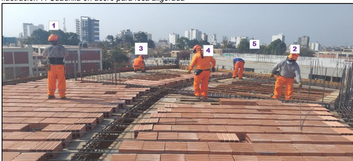
Ilustración 7: Cuadrilla en acero para losa aligerada
