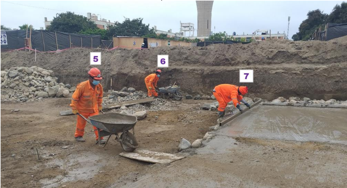
Ilustración 10: Cuadrilla O5 – O7 en concreto para sub cimiento
