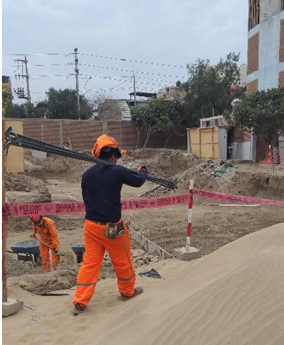
Foto N°3: Transporte de Acero.
