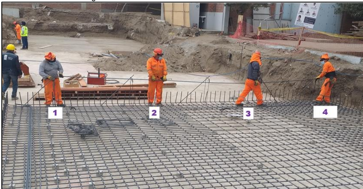
Ilustración 3: Acero en vigas de cimentación
