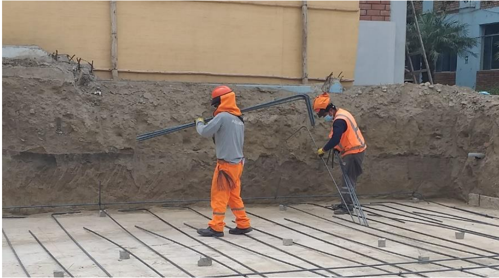
Foto N°7: Colocación de Acero.
