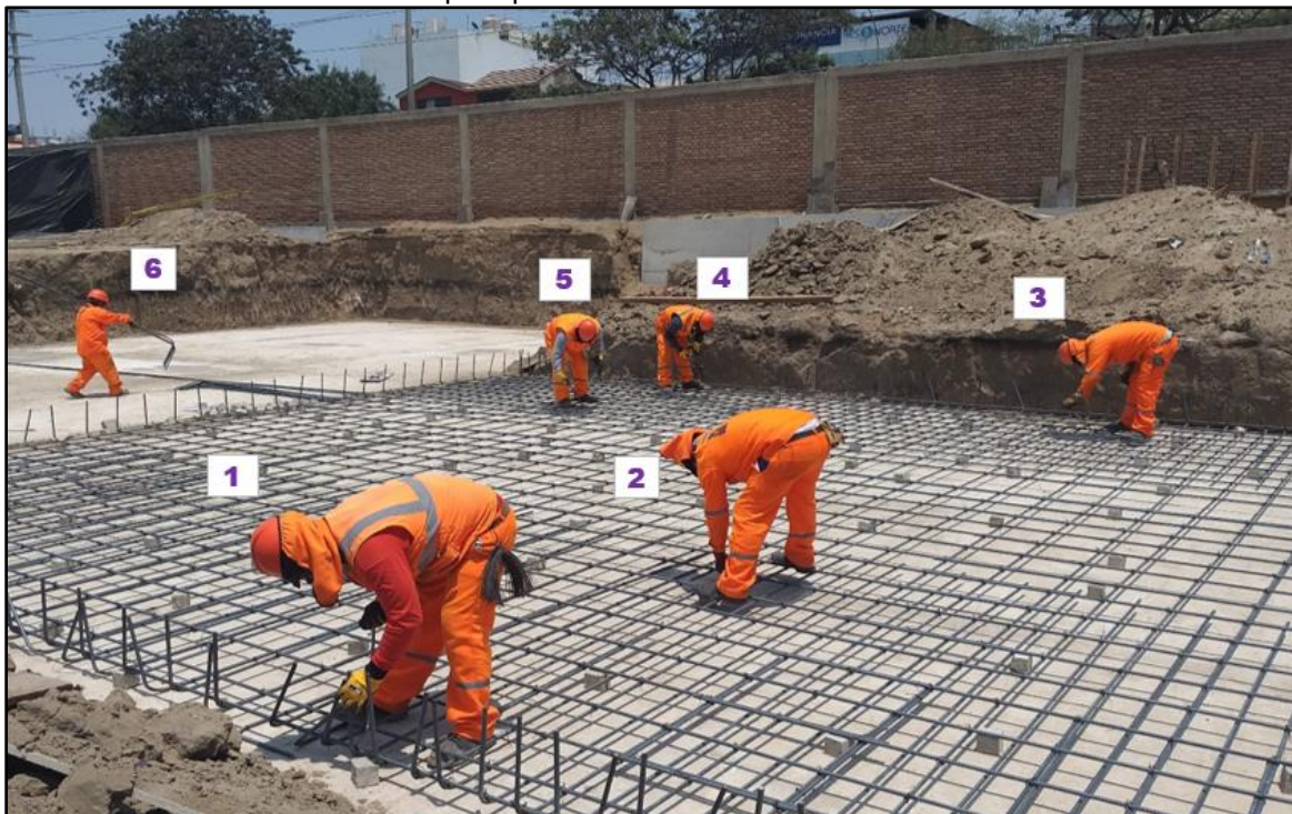
Ilustración 12: Cuadrilla en acero para platea de cimentación
