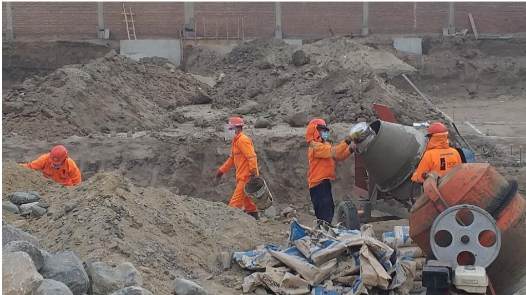
Foto N°20: Abastecer y manejar trompo.
