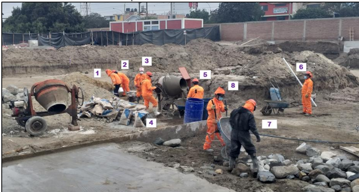
Ilustración 2: Cuadrilla en Concreto para subcimiento
