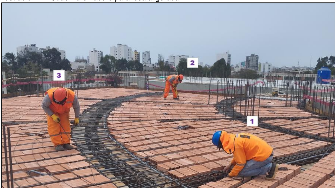
Ilustración 14: Cuadrilla en acero para losa aligerada
