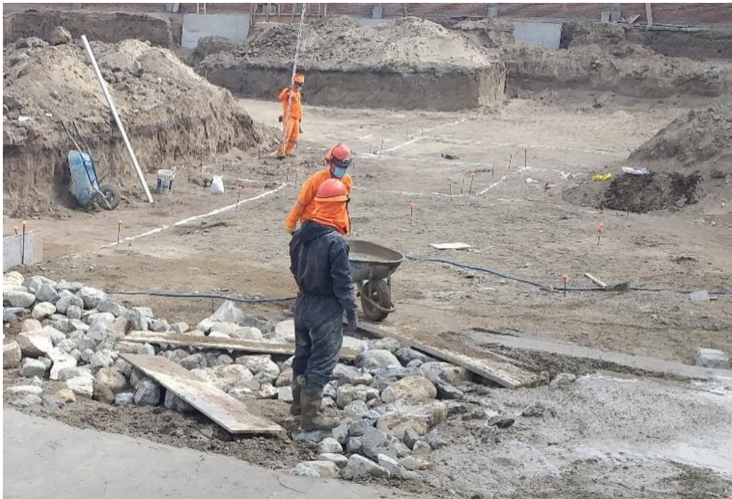
Foto N°22: Espera por Vaceado de mezcla.
