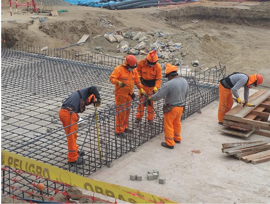
Foto N°26: Colocación de acero.
