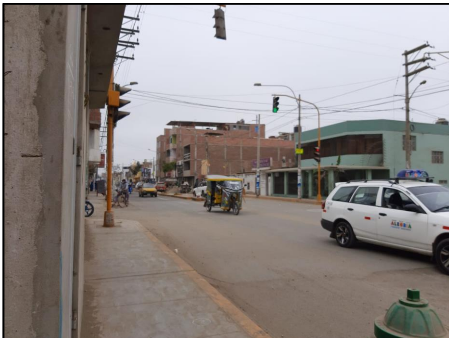
Av. 26 de Marzo (vía de proyección)
