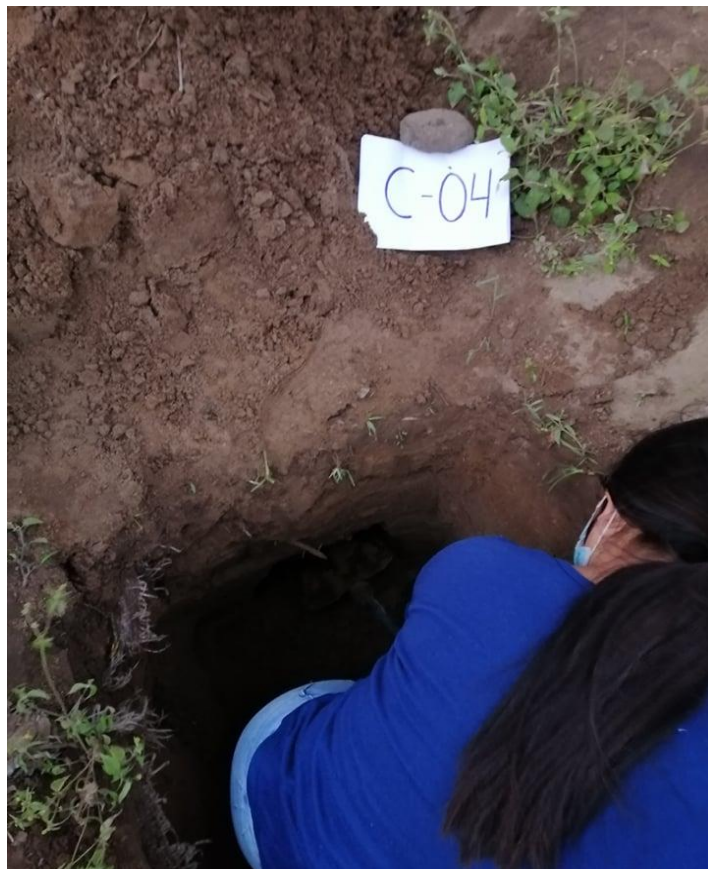
Foto N°8: excavación de la calicata 4, profundidad 1.50m.
