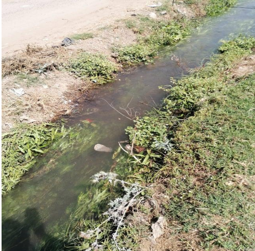
Foto N° 1: estado actual del canal Barrio Nuevo.
