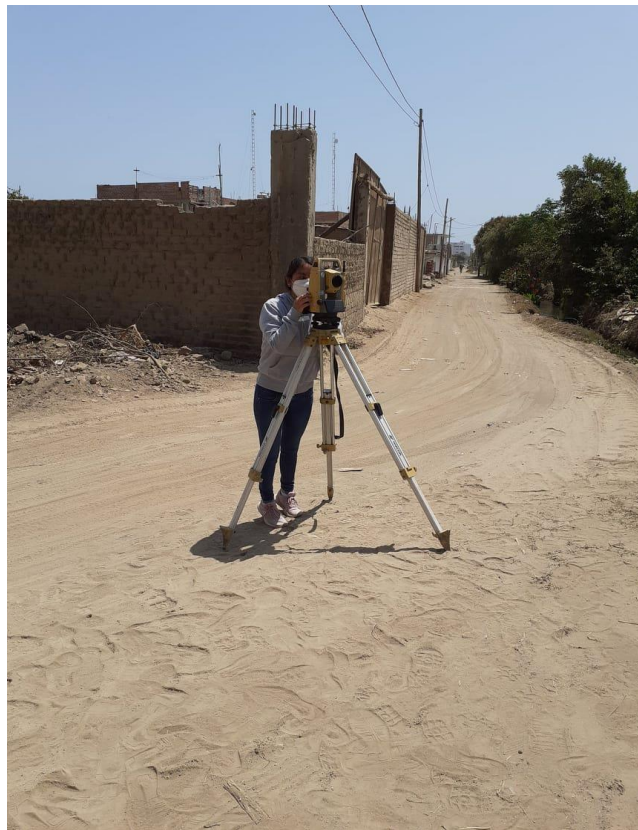
Foto N° 24: levantamiento topográfico de canal Barrio Nuevo.
