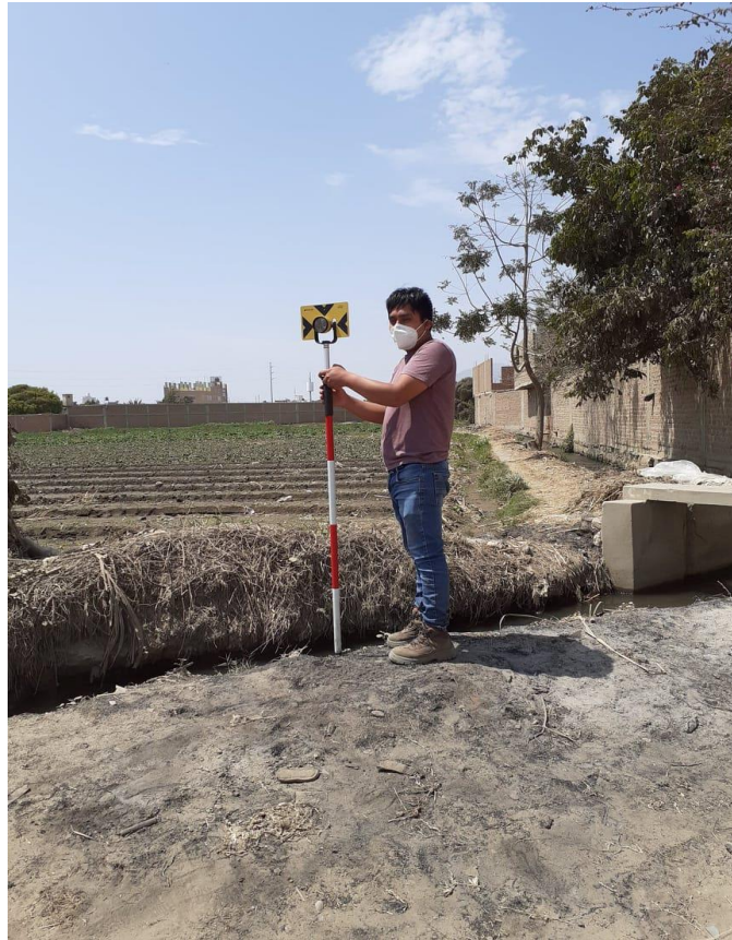
Foto N° 25: tomando niveles de ancho y fondo del canal + terreno.
