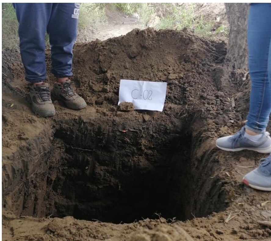
Foto N° 6: excavación de la calicata 2, profundidad 1.50m
