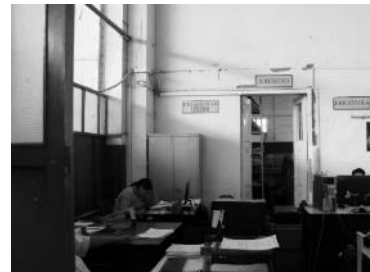
Oficinas con conexiones expuestas
