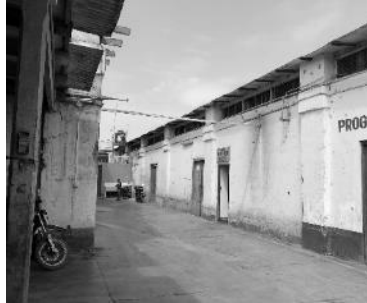
Zonas de circulación en mal estado
