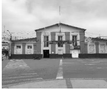
Frontis original deteriorado con pintura
