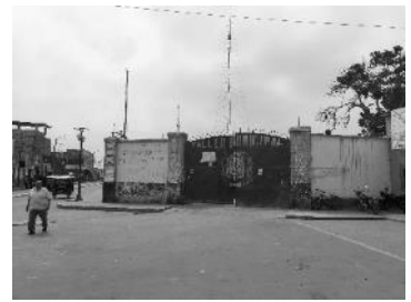
Taller municipal en mal estado
