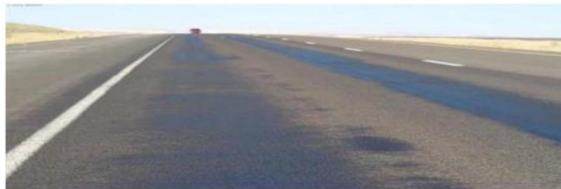
Figura 13: Exudación en pavimentos
