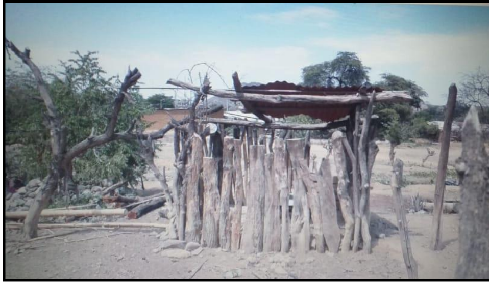
Pozo ciego en vivienda del caserío Pueblo Libre.
