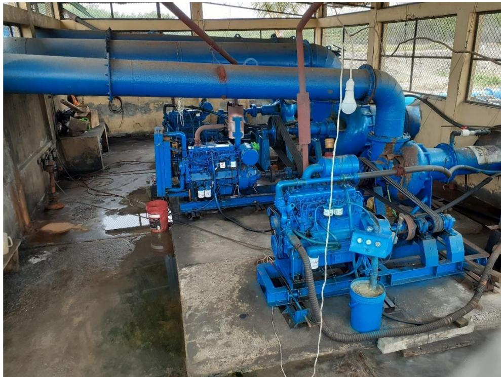
**Se propuso realizar conexiones técnicas, además de sujetar, entubar y ocultar cables, asimismo, mejorar la limpieza y organización de la estación de bombeo.**
