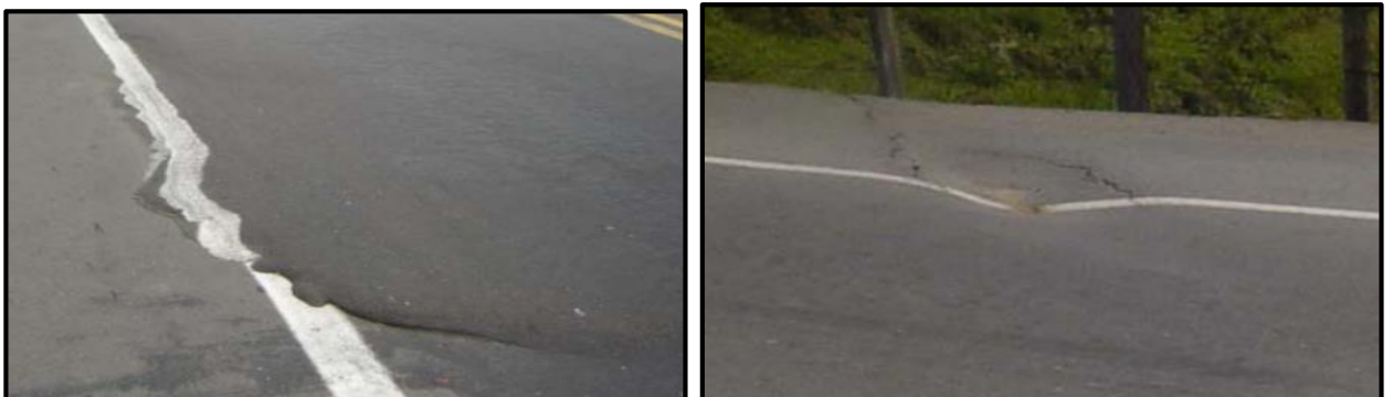
Figura 09: Falla de izquierda Abultamiento y de derecha Hundimiento
