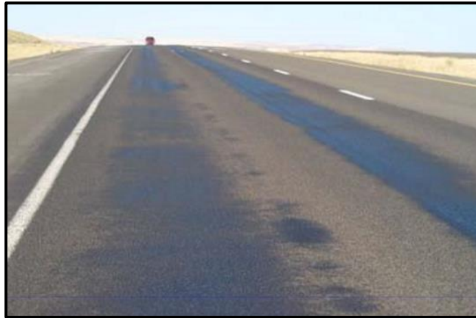
Figura 07. Falla Exudación
