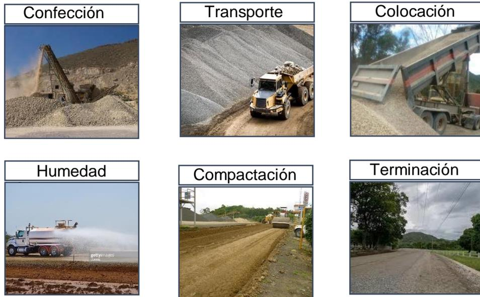
Diagrama 1. Etapas para la preparación de la base en un pavimento flexible.
