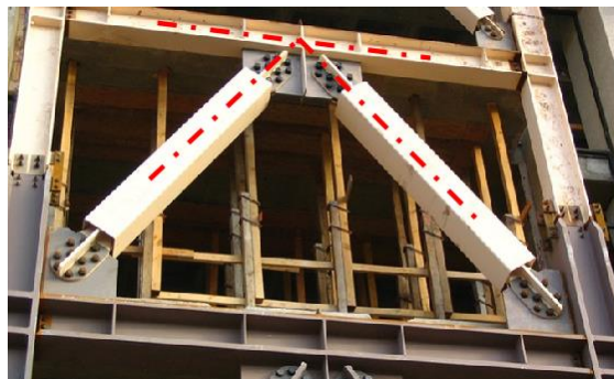
Figura 9 Pórtico con riostra de pandeo restringido
