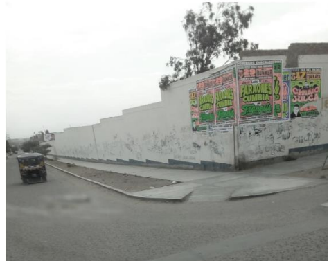
Figura 5. Estado actual del instituto desde el exterior
