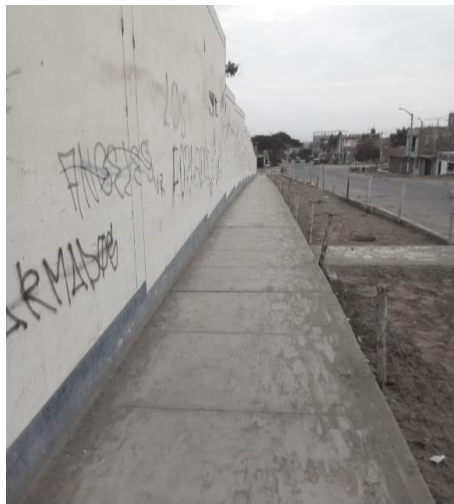
Figura 2. Estado actual del instituto desde el exterior
