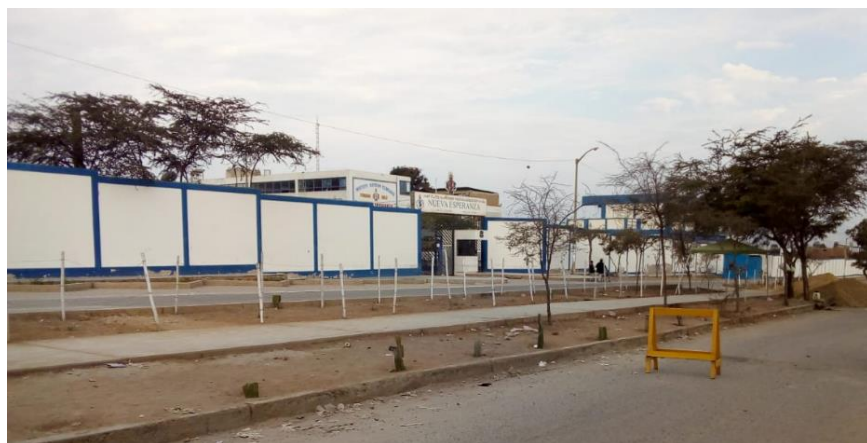
Figura 8. Cerco perimetral que no permite una integración urbana
