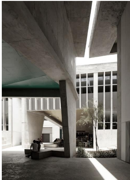
Figura 75: Apreciación del sistema constructivo del pabellón E, UDEP
