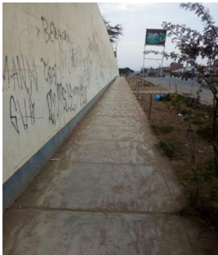
Figura 6. Estado actual del instituto desde el exterior
