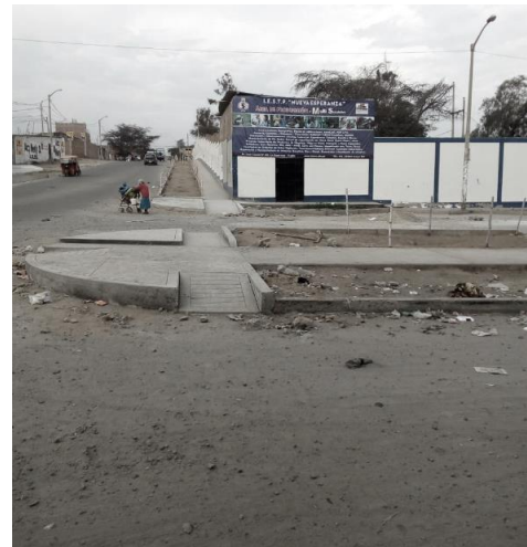
Figura 3. Estado actual del instituto desde el exterior
