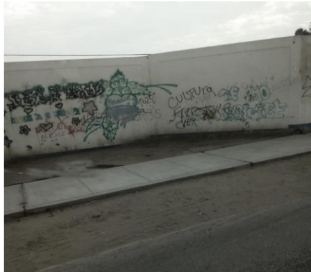
Figura 4. Estado actual del instituto desde el exterior
