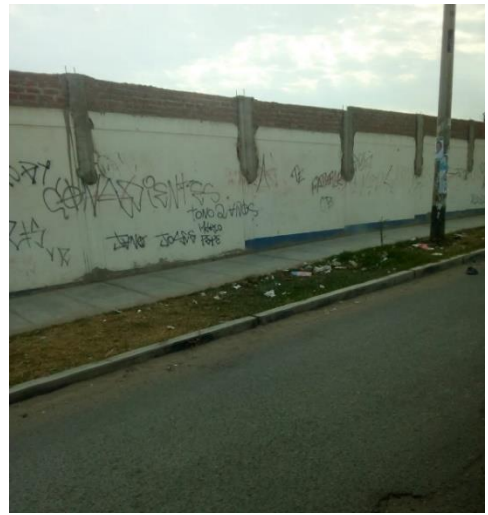
Figura 7. Estado actual del instituto desde el exterior
