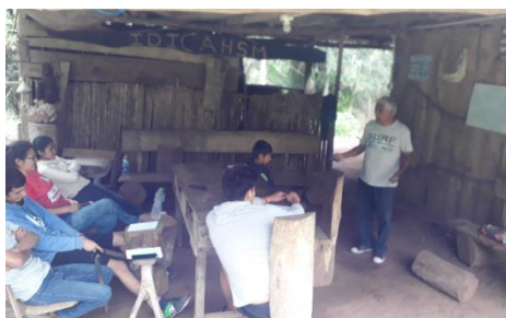
Imagen N°12: Infraestructura construida en el Bosque de los Niños - Interior
