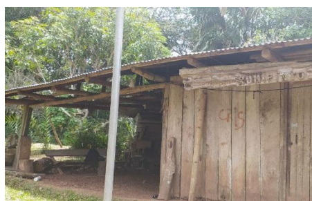
Imagen N°13: Infraestructura construida en el Bosque de los Niños - Exterior
