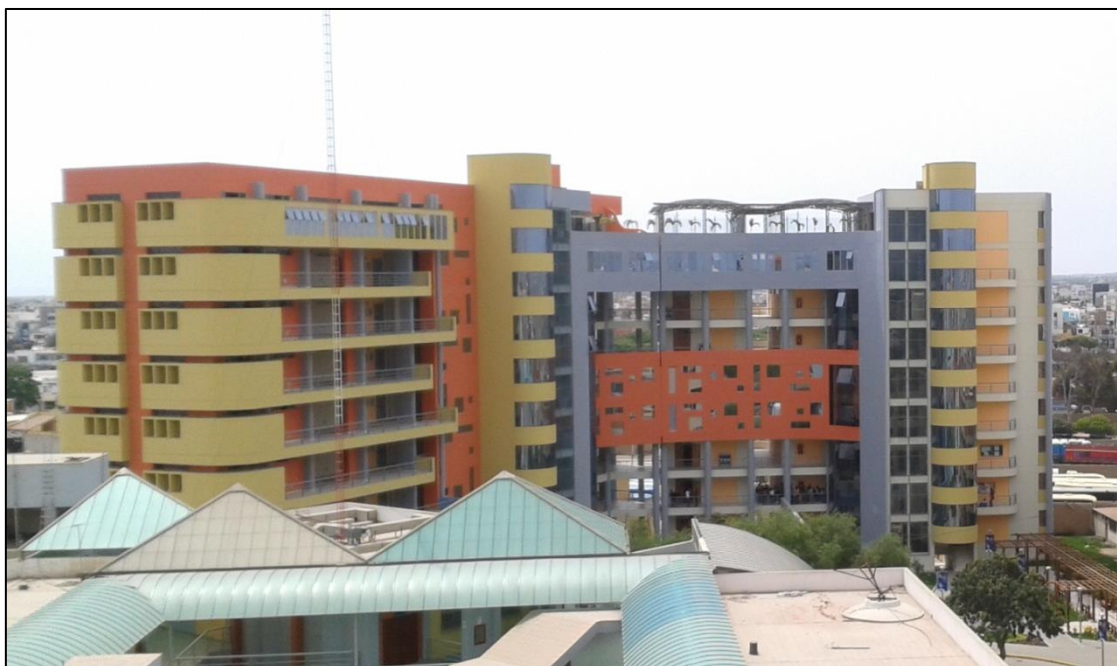
Figura 4.19. Pabellón G de la Universidad Privada Antenor Orrego de Trujillo.
