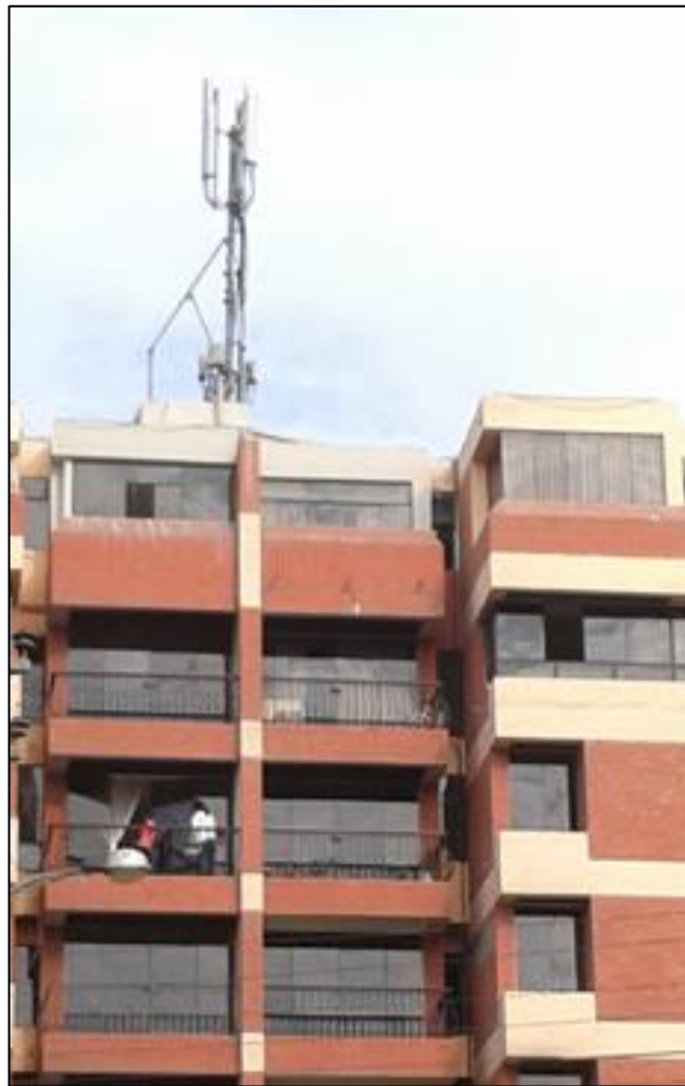
Figura 4.7. Site BTS en Los Ángeles.
