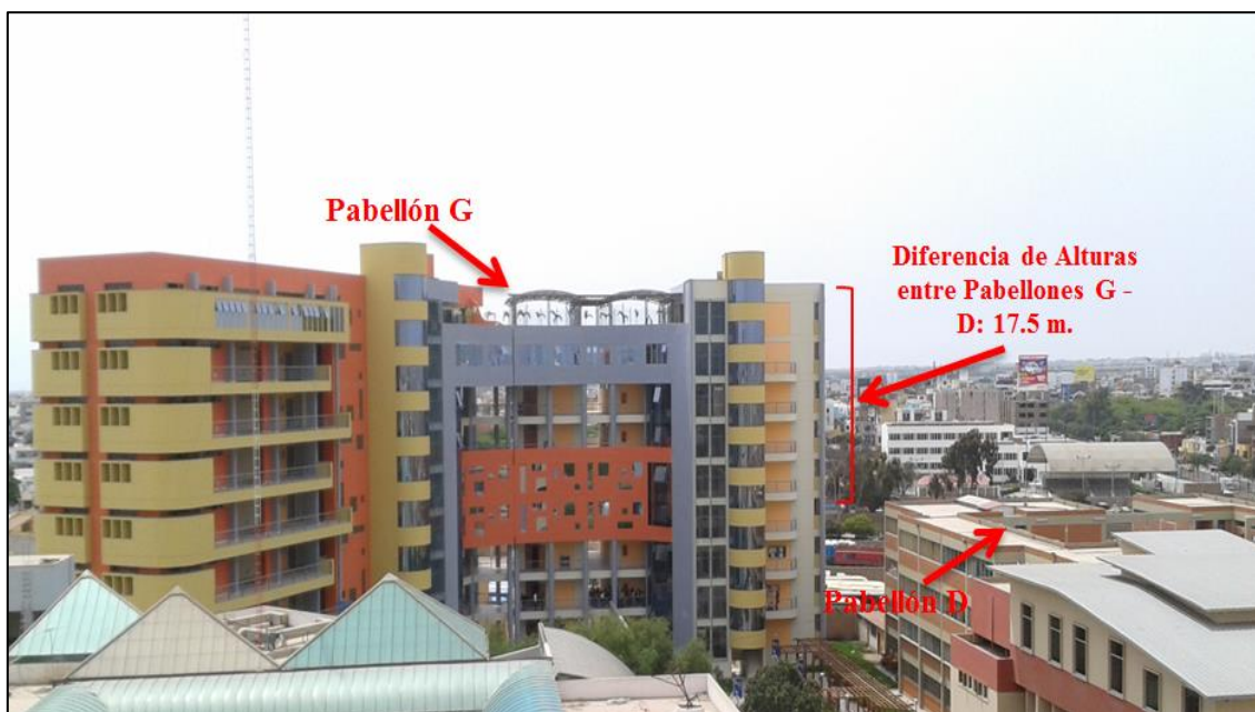
Figura 4.18. Desventaja de instalación de Site en el Pabellón D - UPAO.
