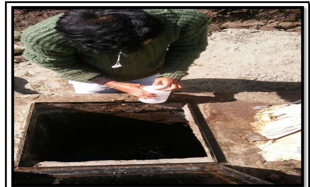
DESCRIPCIÓN FOTO Aforo Realizado en las captación en el Sector La Banda 4
