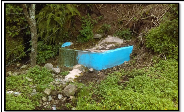
DESCRIPCIÓN FOTO Captación de Agua en Manantial en el Sector las Peñas 5
