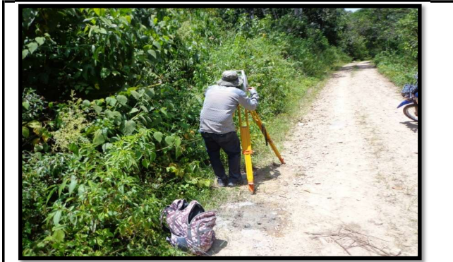
DESCRIPCIÓN FOTO Levantamiento Topografico de la zona del proyecto 1
