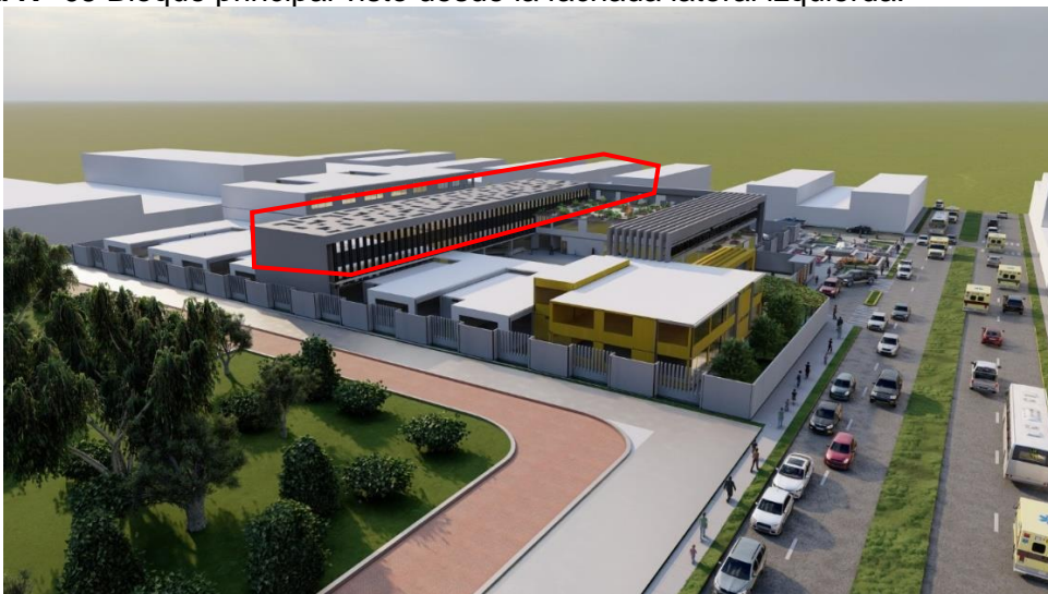
Figura N° 65 Bloque principal visto desde la fachada lateral izquierda.
