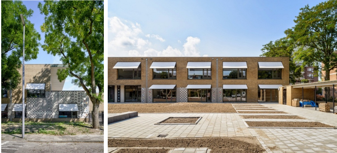
Fotografía N. 5: Entrada principal Escuela de Educación especial en Rotterdam Fuente: Korteknie Stuhlmacer Architecten
