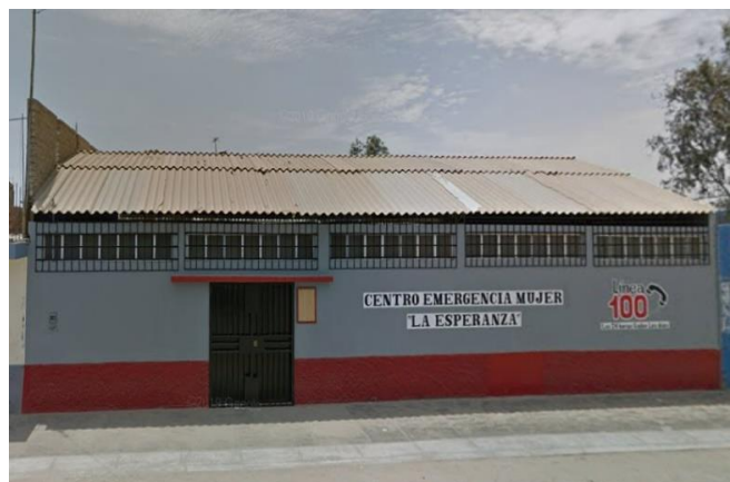
Imagen N° 13: Vista de la fachada CEM, Distrito La Esperanza, Fuente: Google Maps
