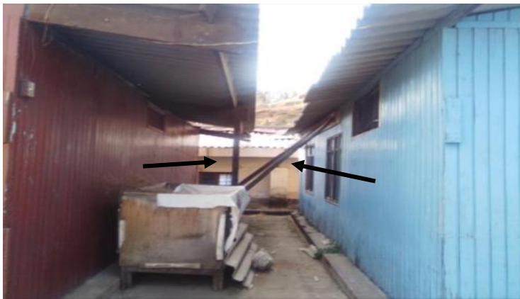
Ilustración 14 Paredes sostenidas por maderas
