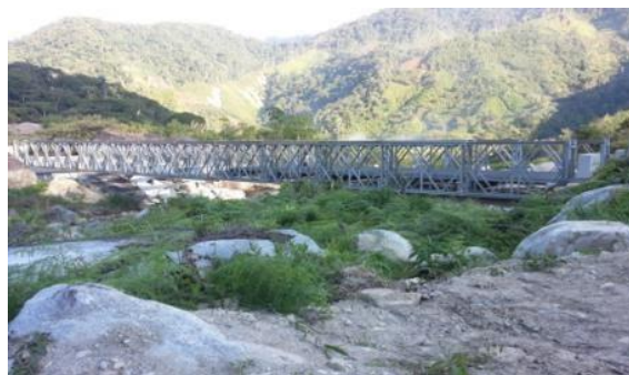
Figura 1.13. Estructura del puente tipo modular “Chagualito”.
