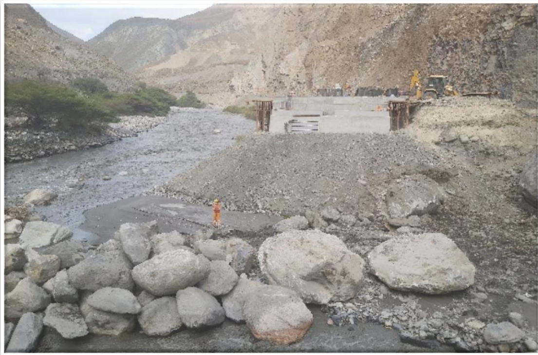
Vista General de estribos donde se instalará el puente reticulado
