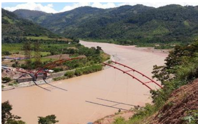
Figura 1.11. Estructura del puente tipo arco
