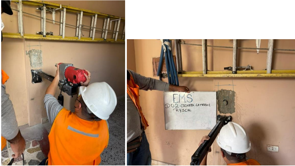
IMAGEN N°03. Ensayo de Inspección Diamantina.
