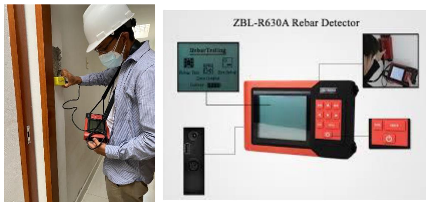
IMAGEN N°06. Ensayo de Inspección Escaneo.
