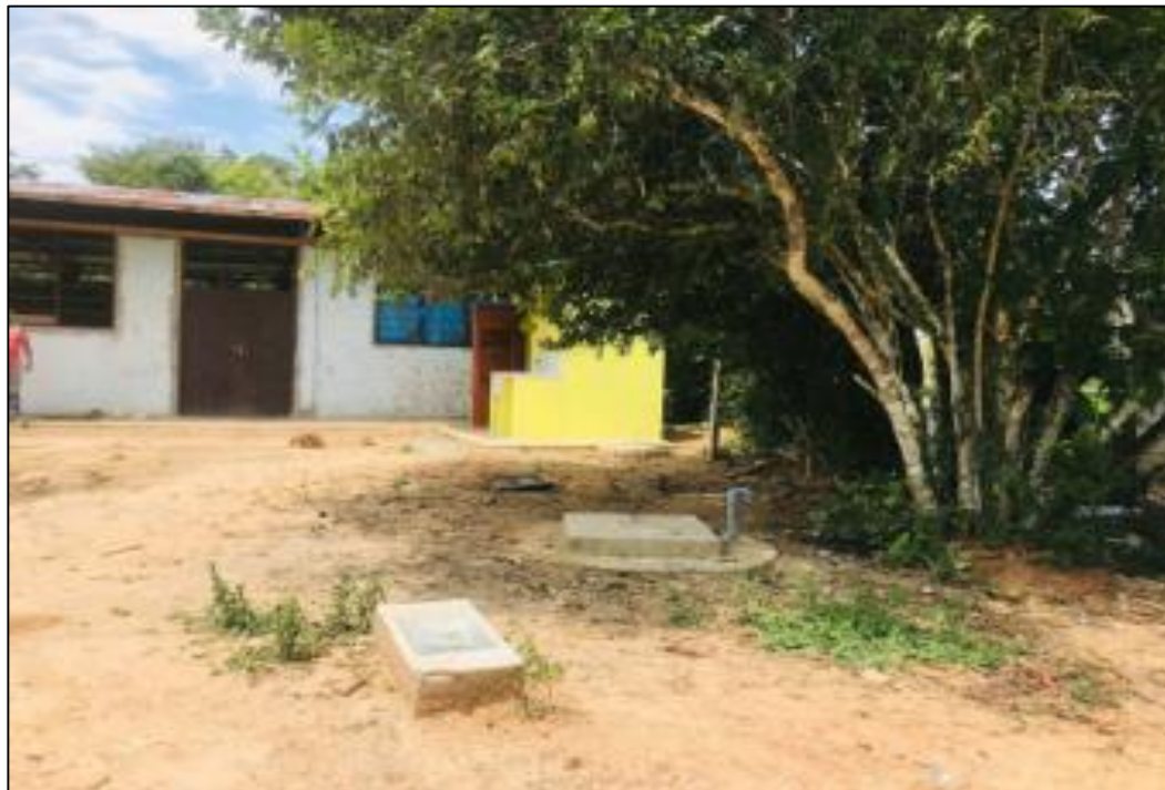
Fotografía 2 Almacén de obra
