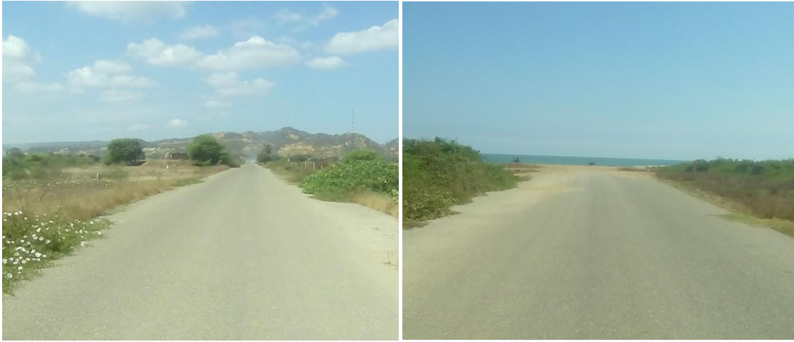
FIGURA 41: VIA PROLONGACIÓN PANAMERICANA NORTE
