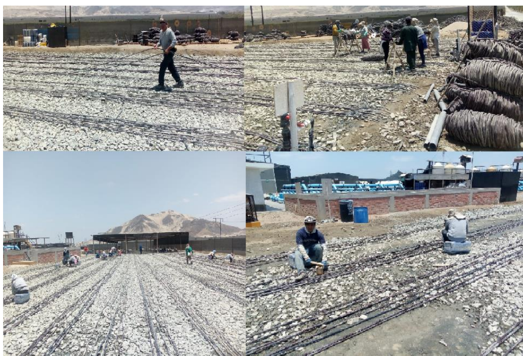
Figura 19. Personal en la labor de mantenimiento de goteros.
