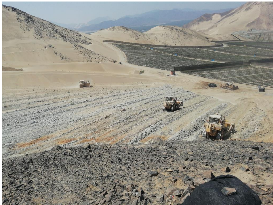
Figura 6. Nivelación gruesa con tractor oruga.
