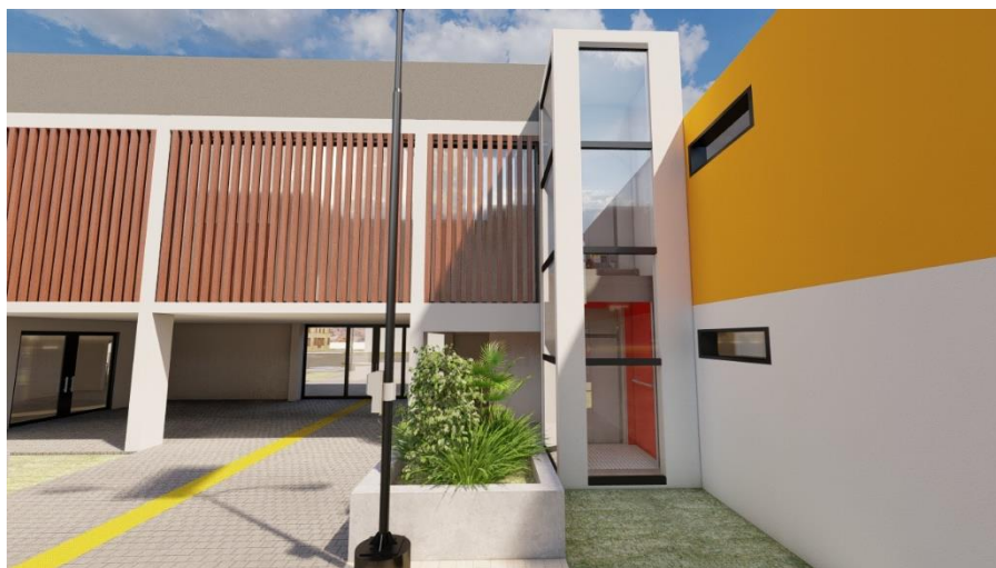
Imagen 64 Vista del elevador
