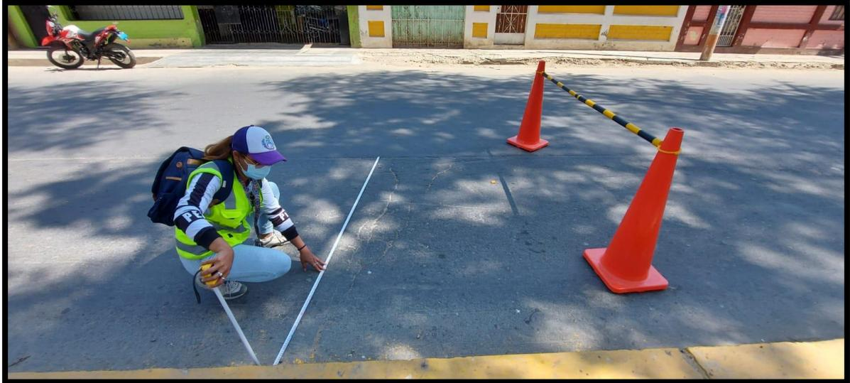
*Figura C35.* Fisuras de nivel de severidad media localizada en la unidad de muestra UM 35 tramo II
