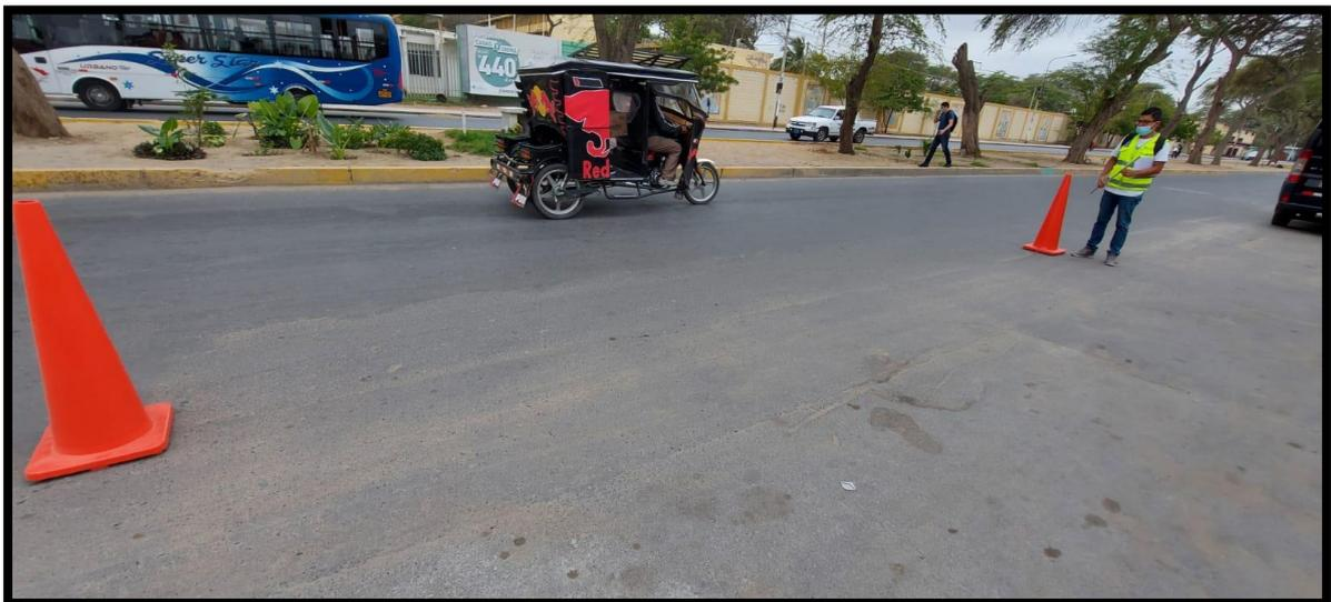
Figura C13. Parches de nivel de severidad media localizada en la unidad de muestra UM 19, tramo II
