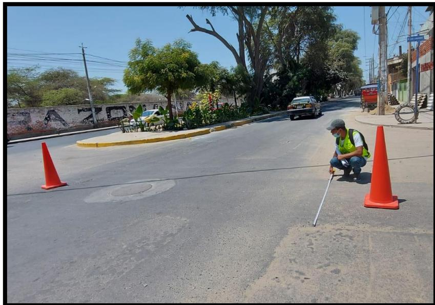
*Figura C26.* Parches de nivel de severidad baja localizada en la unidad de muestra UM 29, tramo II
