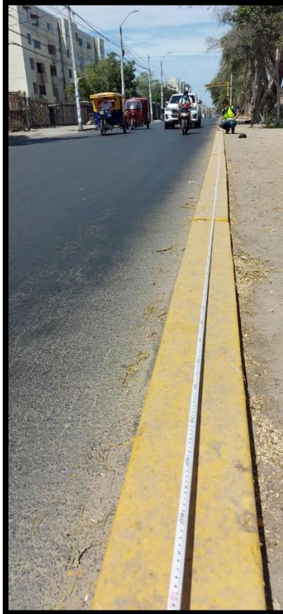
*Figura C3.* Exudación de nivel de severidad baja localizada en la unidad de muestra UM 03, tramo I
