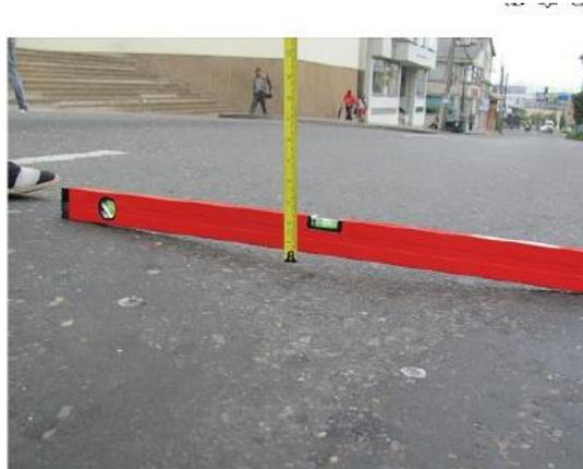
*Figura 13. Ahuellamiento de severidad alta.*
