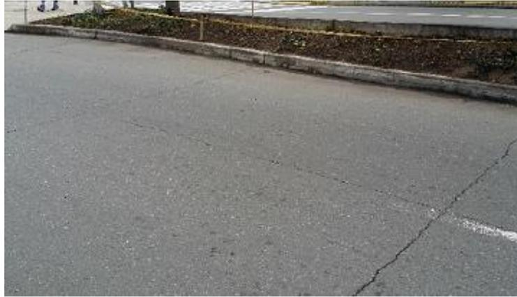
*Figura 7. Fisura de reflexión de junta de severidad baja.*
