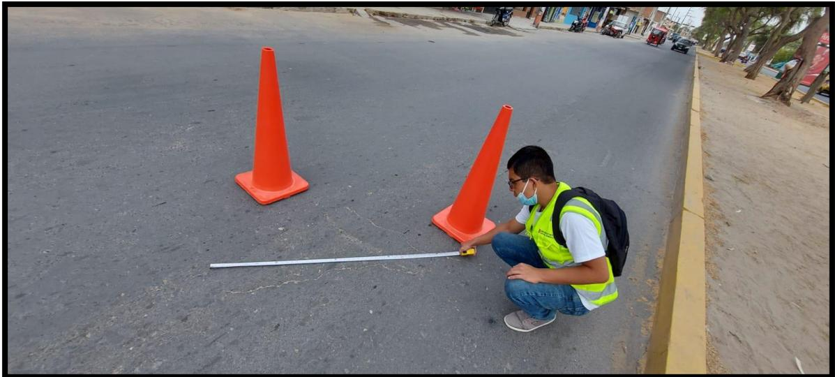
*Figura C20.* Fisuras de nivel de severidad baja localizada en la unidad de muestra
