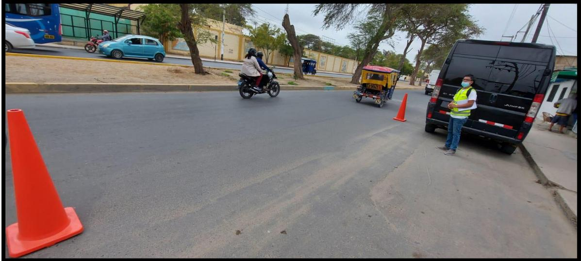
*Figura C14.* Parches de nivel de severidad media localizada en la unidad de muestra UM 19, tramo II
