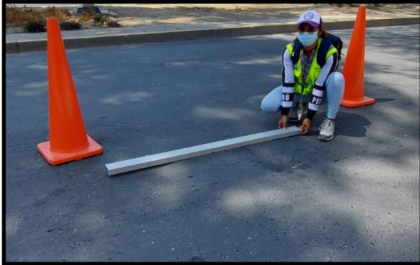
*Figura C32.* Abultamiento y hundimiento de nivel de severidad baja localizada en la unidad de muestra UM 33 tramo II
