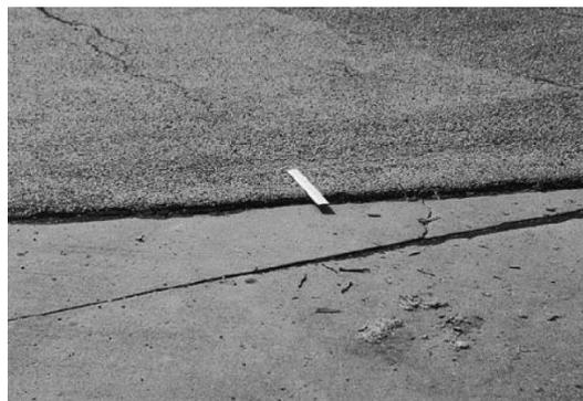
*Figura 14. Desplazamiento de severidad media.*
