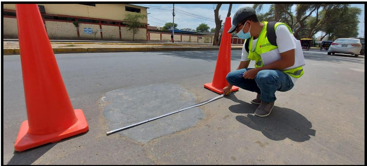
*Figura C22.* Parches de nivel de severidad alto localizada en la unidad de muestra UM 25, tramo II
