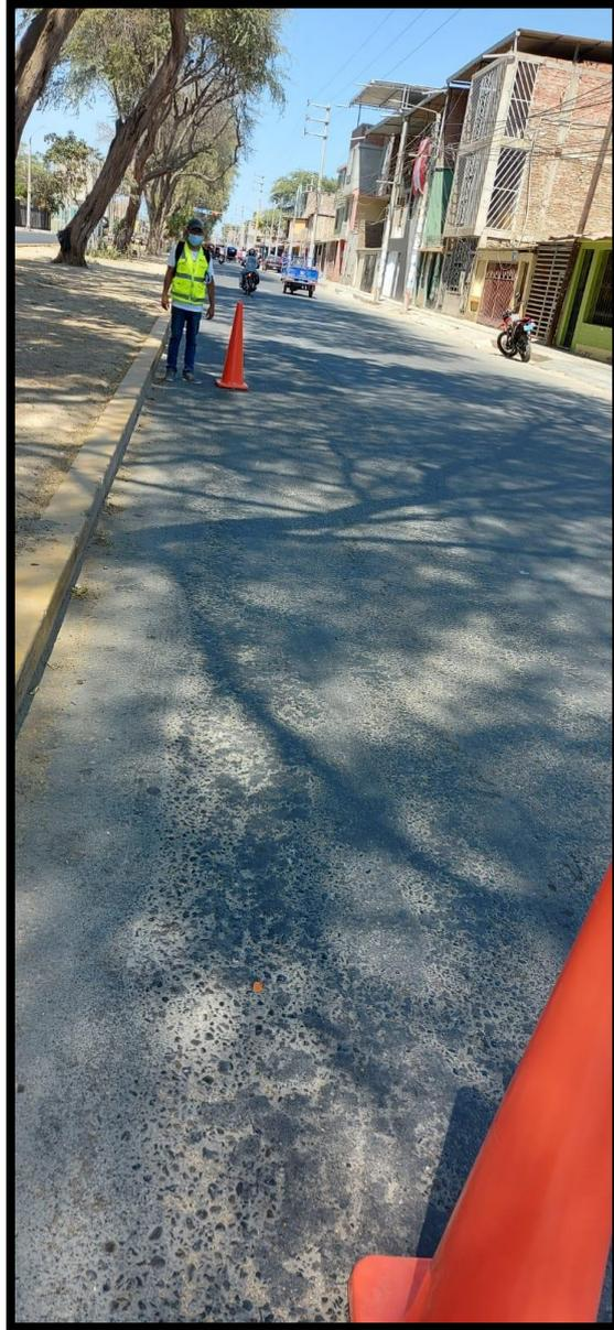
*Figura C34.* Desgaste por intemperismo de nivel de severidad baja localizada en la unidad de muestra UM 35 tramo II
