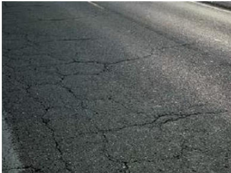
*Figura 6. Fisura en bloque de severidad alta.*
