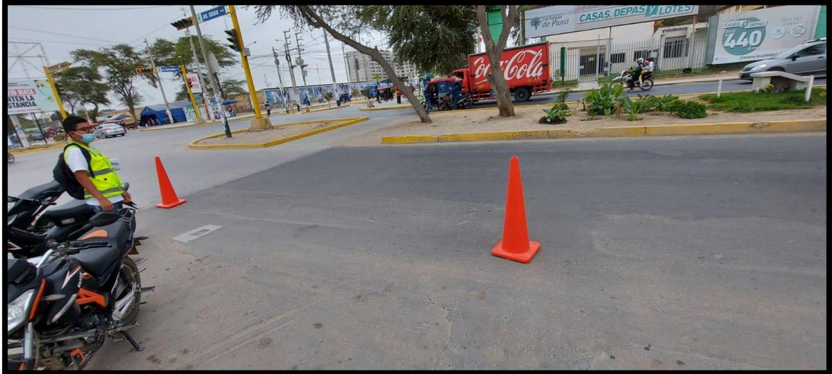
Figura C12. Parches de nivel de severidad media localizada en la unidad de muestra UM 19, tramo II
