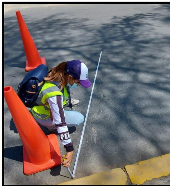
*Figura C31.* Fisuras de nivel de severidad baja localizada en la unidad de muestra
