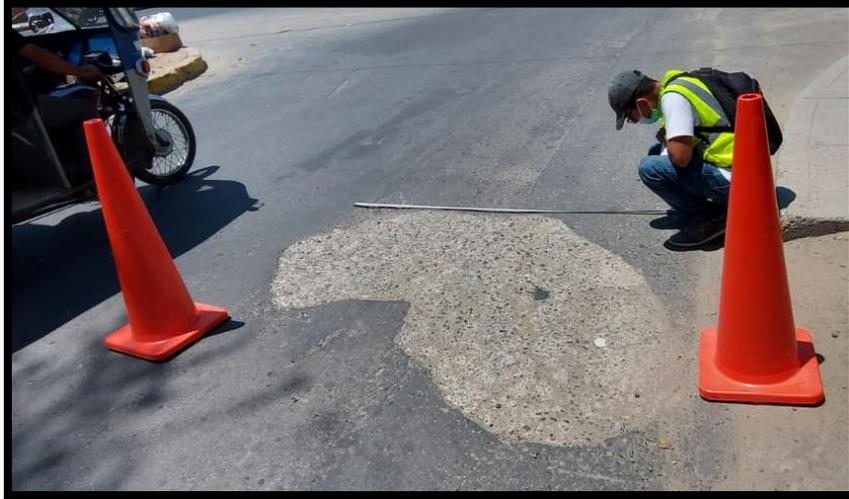
*Figura C25.* Fisuras de nivel de severidad alta localizada en la unidad de muestra UM 27, tramo II
