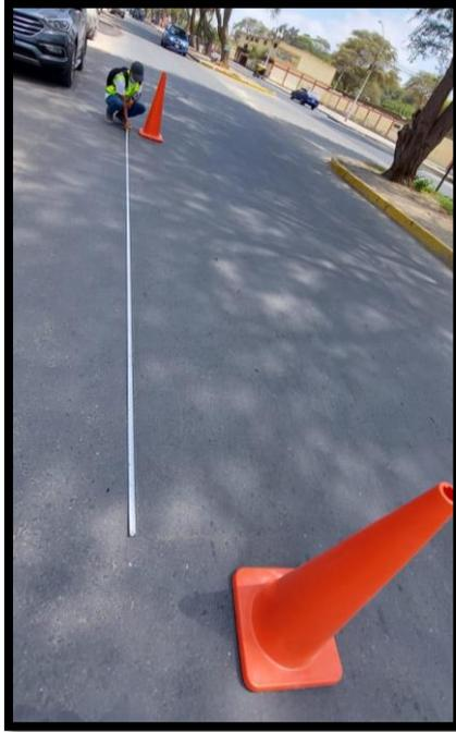
*Figura C23.* Parches de nivel de severidad baja localizada en la unidad de muestra UM 25, tramo II
