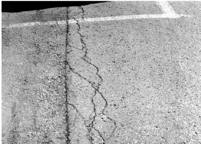
*Figura 5. Fisura de borde de severidad media.*
