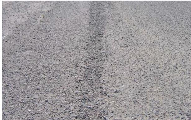
*Figura 18. Desprendimiento de agregado de severidad alta.*
