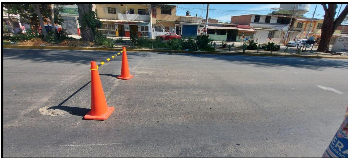
*Figura C7.* Desgaste por intemperismo de nivel de severidad media localizada en la unidad de muestra UM 09, tramo I
