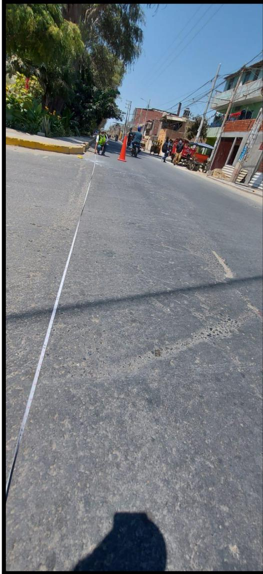
*Figura C27.* Parches de nivel de severidad baja localizada en la unidad de muestra UM 29, tramo II
