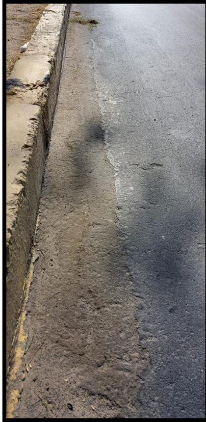
*Figura C11.* Desprendimiento de agregado de nivel de severidad baja localizada en la unidad de muestra UM 17, tramo I
