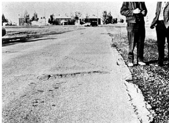
*Figura 10. Abultamiento y hundimiento de severidad media.*
