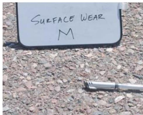
*Figura 17. Meteorización de severidad media.*
