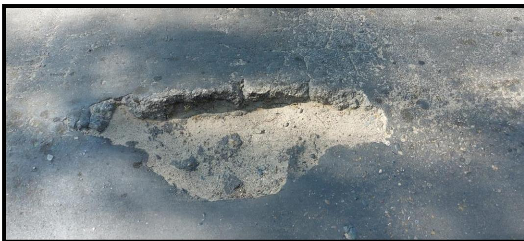
*Figura C6.* Baches de nivel de severidad alto localizada en la unidad de muestra UM 09, tramo I
