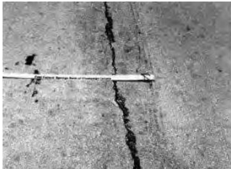
*Figura 8. Fisura longitudinal y transversal de severidad media.*
