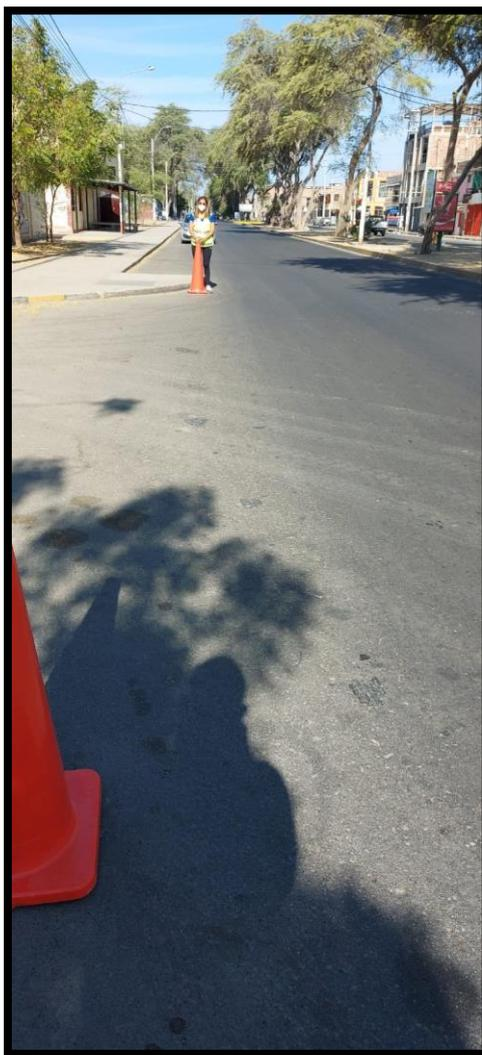
*Figura C10.* Exudación de nivel de severidad baja localizada en la unidad de muestra UM 15, tramo I
