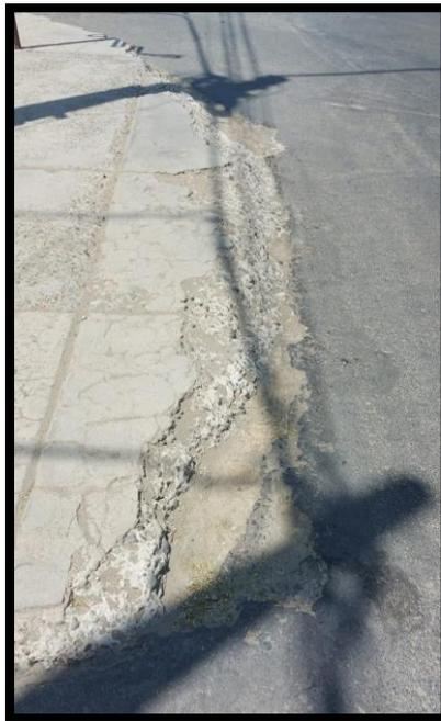
*Figura C1.* Fisura de borde de nivel de severidad media localizada en la unidad de muestra UM 01, tramo I
