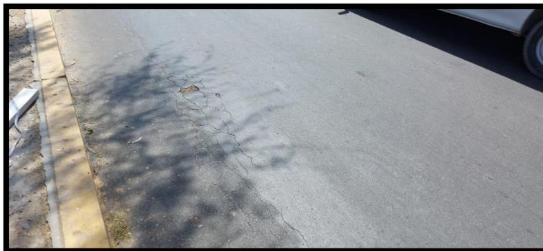
*Figura C4.* Piel de cocodrilo de nivel de severidad baja localizada en la unidad de muestra UM 05, tramo I
