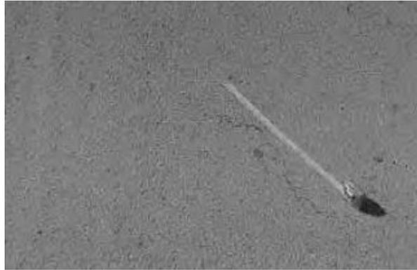
*Figura 9. Fisura por deslizamiento de severidad leve.*
