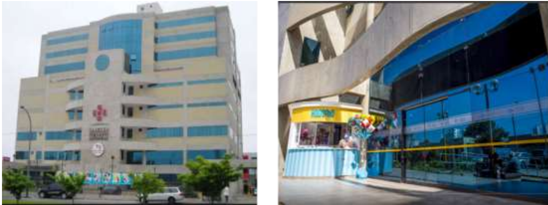
FIGURA 78 Fachada principal e ingreso
