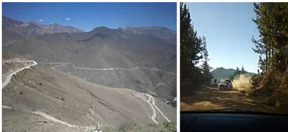
FIGURA 6 Izquierda, carretera afirmada hacia el distrito de Ayabaca, Derecha, carretera hacia el distrito de Montero
