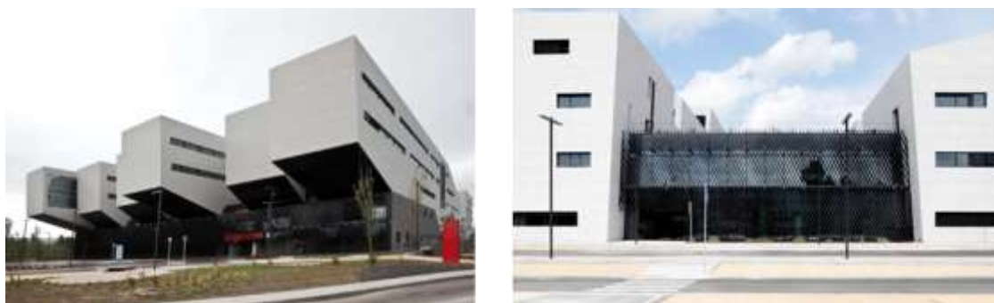
FIGURA 88 vista general e ingreso del hospital general de Villalba.
