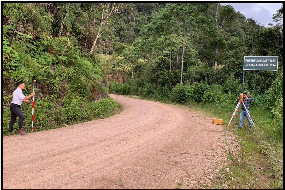
Figura N° 5: Levantamiento topográfico de ancho de calzada existente progresiva 13+135.
