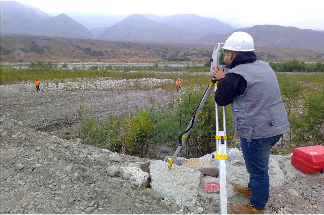
Fotografía 1: Se aprecia en la imagen el levantamiento topográfico en el BM-1 ubicado corona del dique existente margen derecho aguas abajo.
