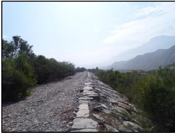
Estructuras de fijación del lecho - Vista hacia aguas arriba.
