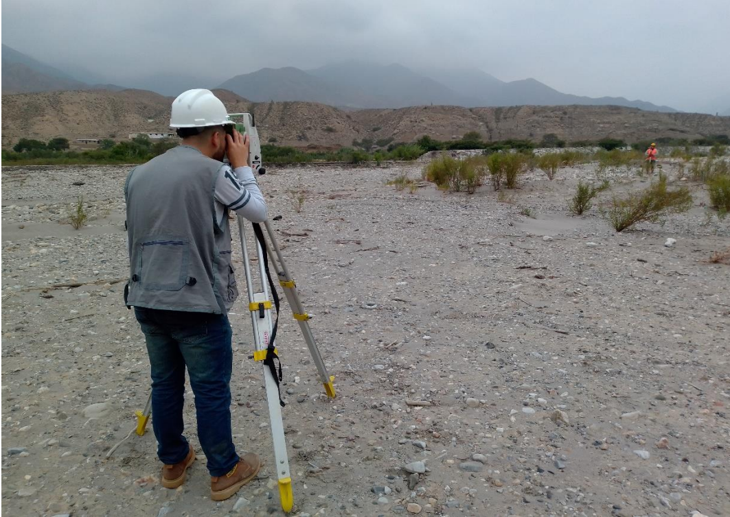
Fotografía 5: Se aprecia en la quinta imagen el levantamiento topográfico en el lecho de río Chicama en el tramo el Algarrobo.
