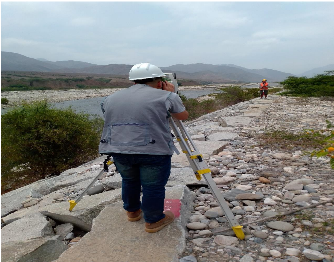
Fotografía 6: Se aprecia en la imagen el levantamiento topográfico en la corona de dique existente margen derecho aguas abajo en el BM-3 cerrando la poligonal .
