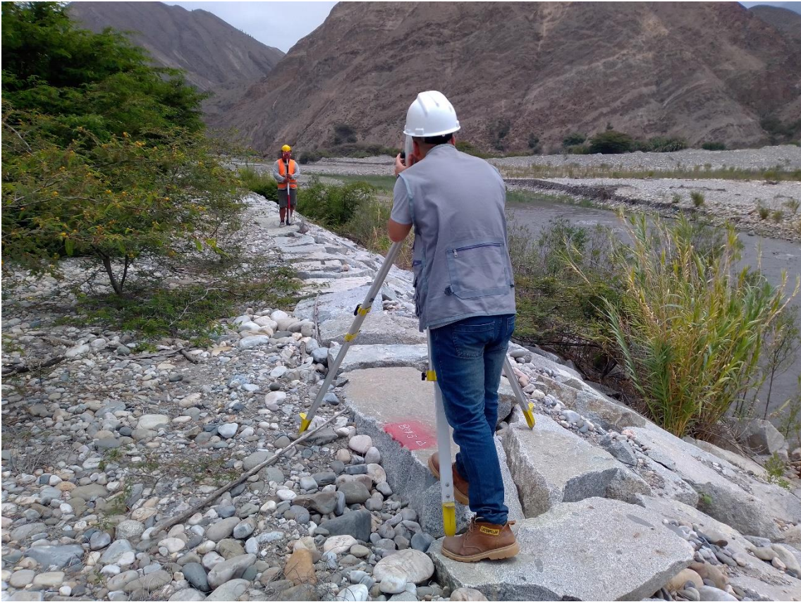
Fotografía 7: Se aprecia en la siguiente imagen el levantamiento topográfico en la corona de dique existente margen derecho aguas abajo en el BM-3 cerrando la poligonal.
