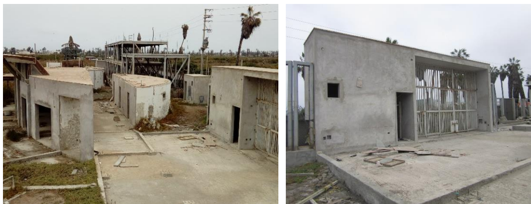
Imagen 39: Situación actual de la infraestructura
