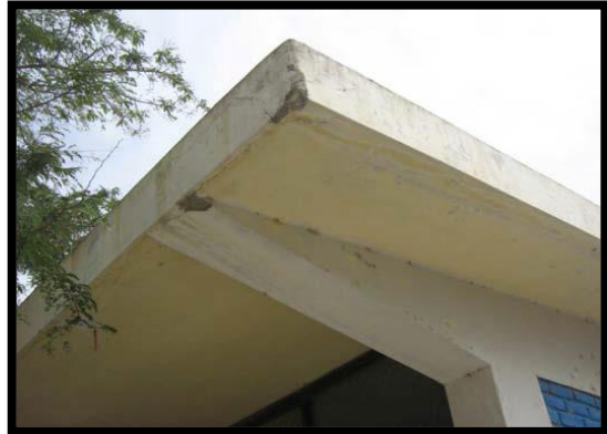
Cobertura de los Pabellones Antiguos
