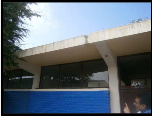
Cobertura de los Pabellones Antiguos
