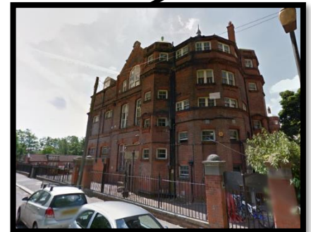
Imagen N° 147: Colegio Primaria Puente Piedra
