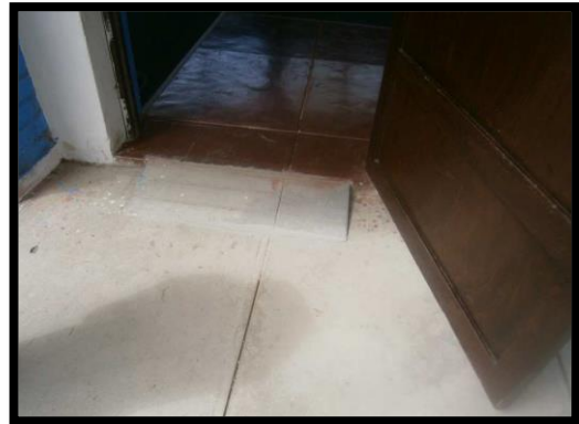
Ingreso a Pabellones de Aulas
