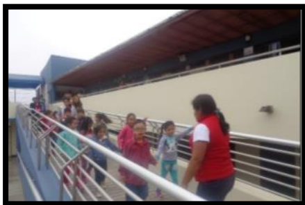
Imagen N°101: Estructuración de Rampa del Centro Ann Sullivan
