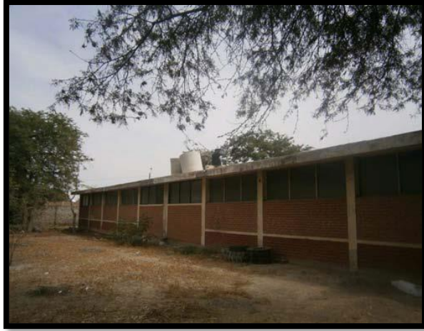
Tanque Elevado en uno de los Pabellones
