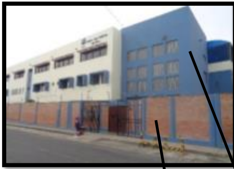
Imagen N°99: Fachada del Centro Ann Sullivan
