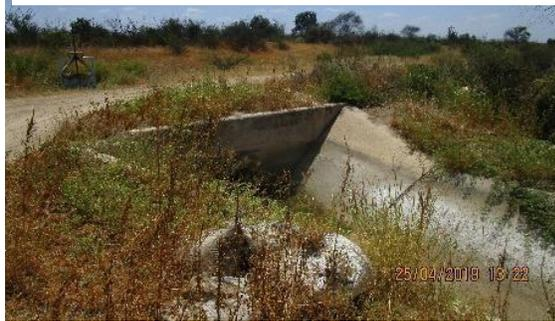
**Canal de 3er Orden Don Limón:** Inicia en la progresiva  $1 + 470$  km. a la margen izquierda del canal de segundo orden T – 52 Luis de la Puente, compuerta de captación buen estado con un ancho de 0.5 m. y una altura de 2.5 m, de longitud de 1.07 km. totalmente de geomembrana con una sección tipo trapezoidal de base menor 0.40 m., base mayor 1.72 y una altura 0.60 m.
