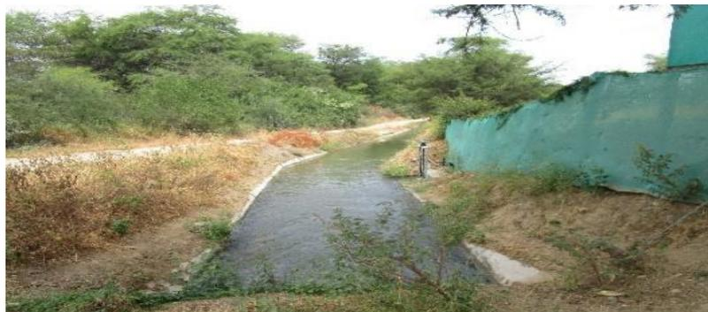
**Canal de 3er. Orden 3 + 300 - Izquierda:** Inicia en la estructura de concreto partidor en la progresiva 3 + 300 km. ala margen izquierda del canal de segundo orden T - 39.4-I, tiene una longitud de 1.06 km. totalmente sin revestir en pésimo estado de conservación, de sección irregular tipo trapezoidal con una base menor 0.50 m., base mayor 1.72 m., y una altura 0.4 m., con un caudal de operación de  $0.06 \text{ m}^3/\text{s}$ .
