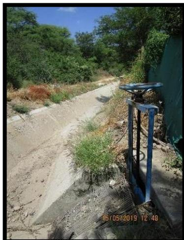
Compuerta de captación de la empresa AGROVALKO, ubicado en las coordenadas UTM 553670 ESTE - 9466686 NORTE, en buenas condiciones, primera compuerta del lateral de 2do. Orden T 39.4 I.
