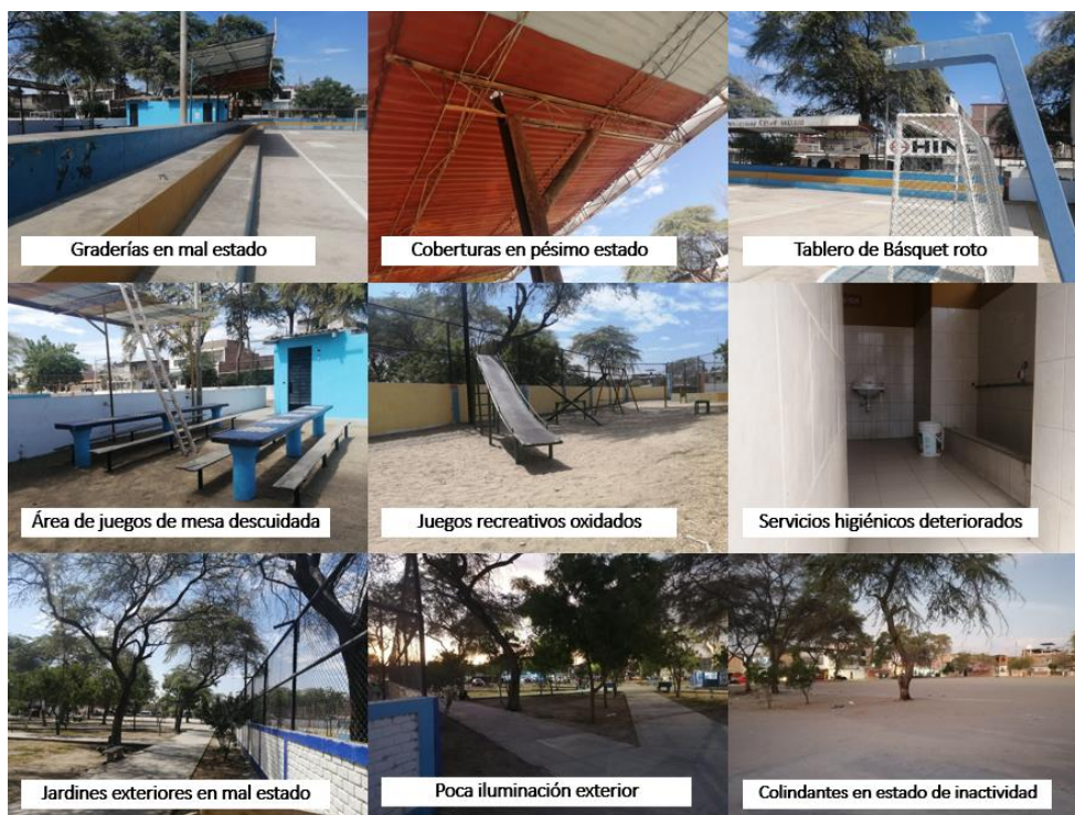
Imagen 5. Evidencia de la mala infraestructura del Coliseo Municipal Indoamérica
