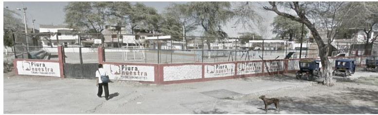
Imagen 4. Fotografía de estado actual del Coliseo Municipal Indoamérica
