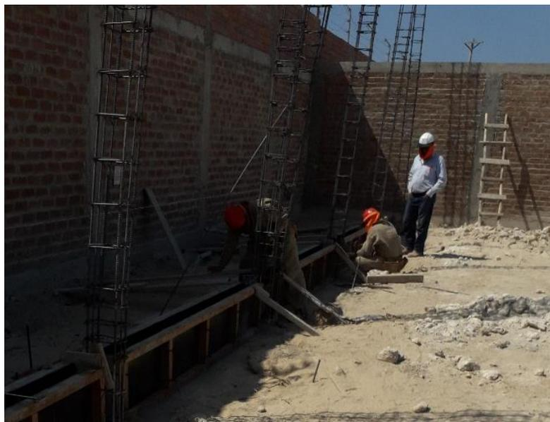
**Figura 60.** *Verificación en trabajos de encofrado de sobrecimientos*
