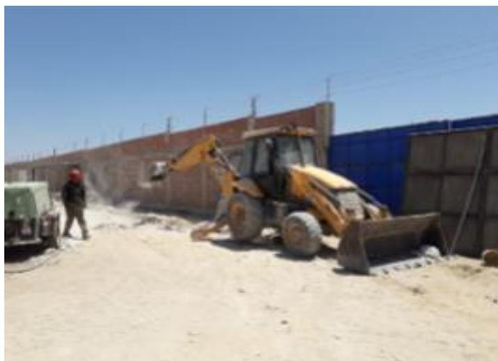
**Figura 9.** Trabajos de Retroexcavadora en conjunto con compresora de aire y martillo neumáticos son truncados debido a la dureza del terreno
