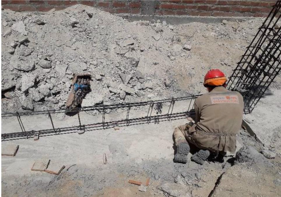
**Figura 57.** Verificación de acero en Sobrecimientos antes del proceso de encofrado
