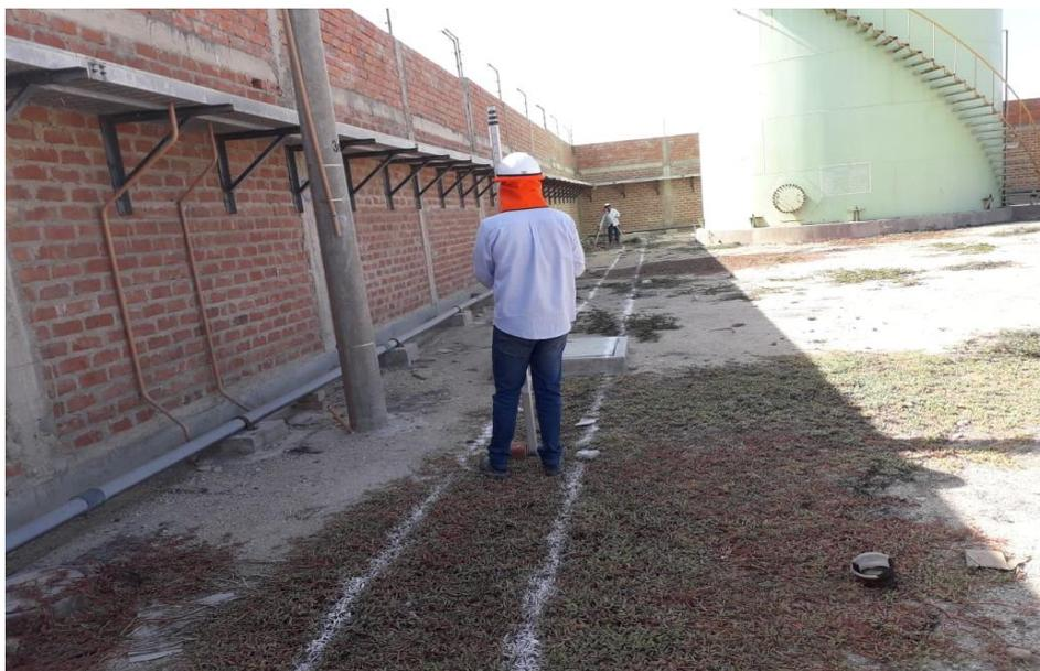
**Figura 4.** *Replanteo en Zona 1 de la Estación de Gas*
