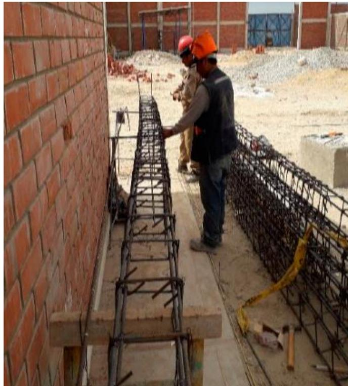
**Figura 56.** Verificación de acero en Columnas antes del izaje en excavación de cimientos
