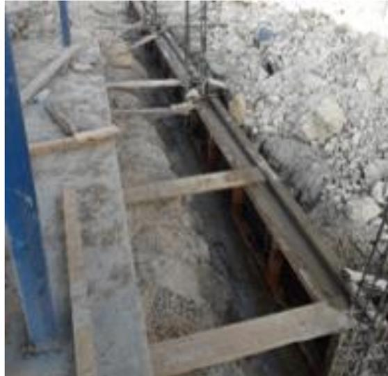
**Figura 10.** Trabajos defectuosos de encofrado de sobrecimiento armados.
