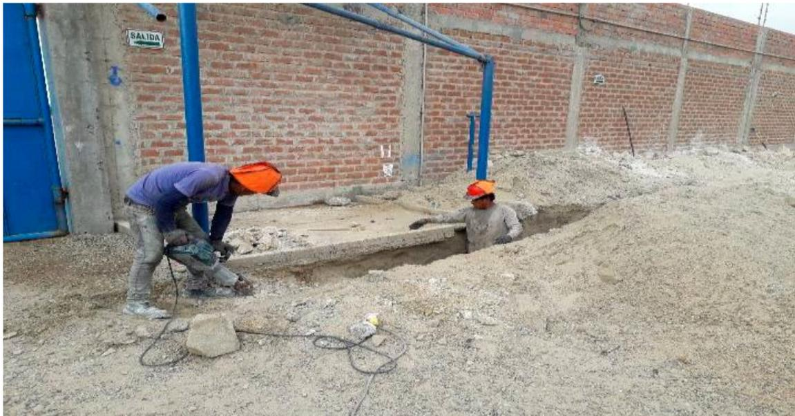
**Figura 53.** Continuación de trabajos con Rotomartillos eléctricos
