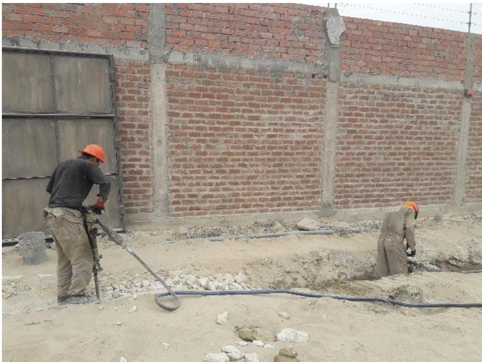
**Figura 58.** *Ejecución de trabajos con personal especializado en excavaciones de suelo rocoso*
