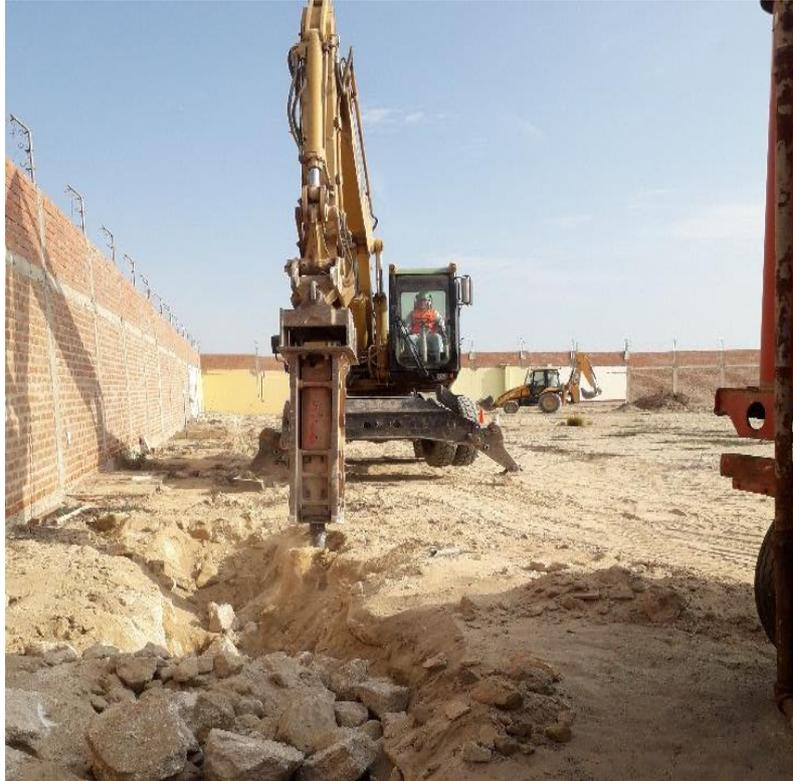
**Figura 59.** *Ejecución de trabajos de excavación en zona rocosa con Excavadora con Martillo Hidráulico*
