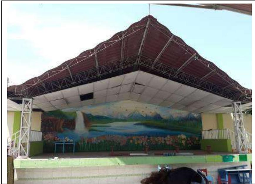
En esta fotografía se observa que en Patio Multiusos, presenta una cobertura liviana con estructura metálica deteriorada.
