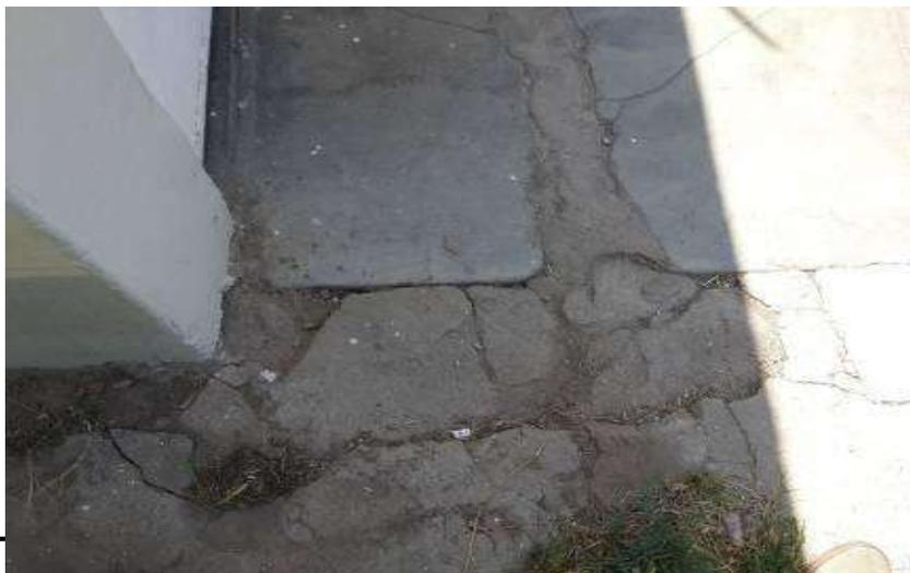
En esta fotografía se observa que la superficie presenta rajaduras y desprendimiento del concreto. En esta área la superficie se encuentra deteriorada, agrietada y erosionada, lo cual representa un riesgo de sufrir lesión para los alumnos
