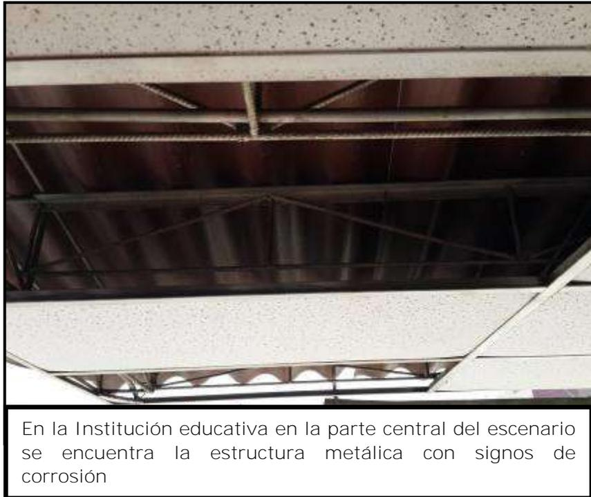
Figura 21: Coberturas deterioradas
