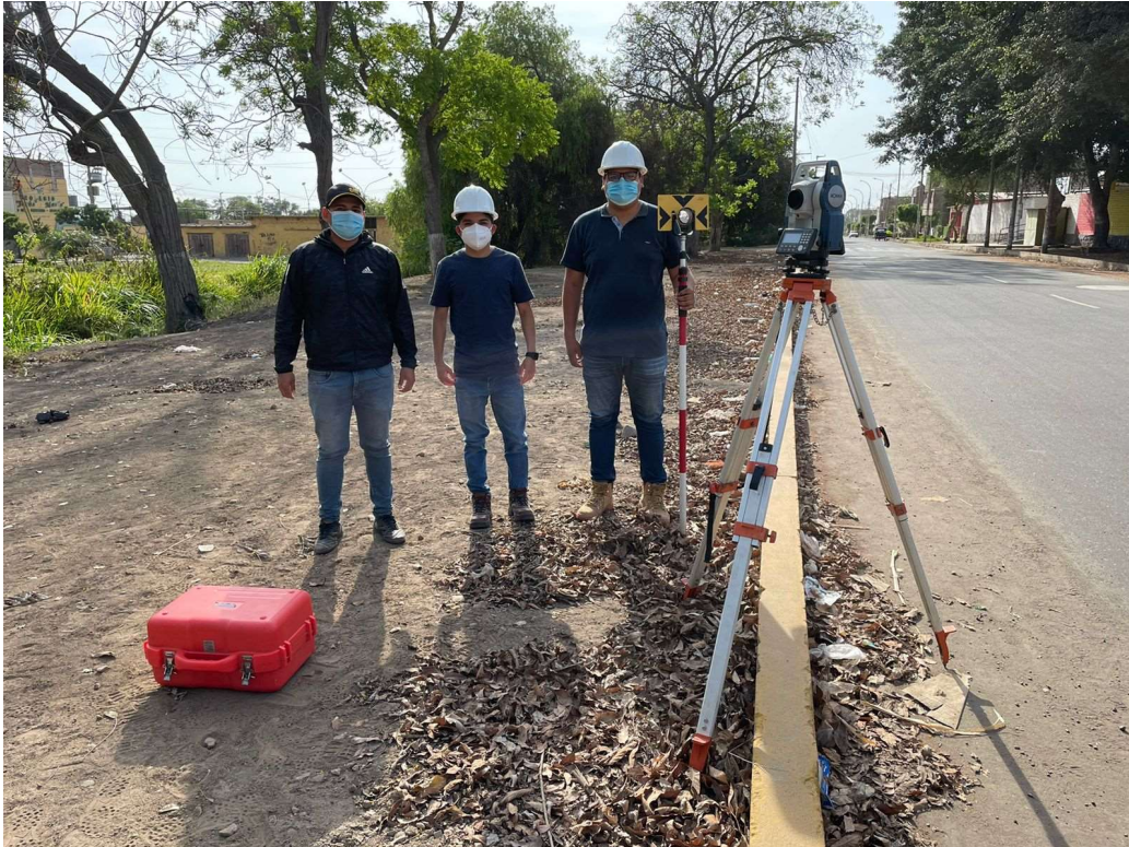
Fotografía 09: Culminación del levantamiento Topográfico.
