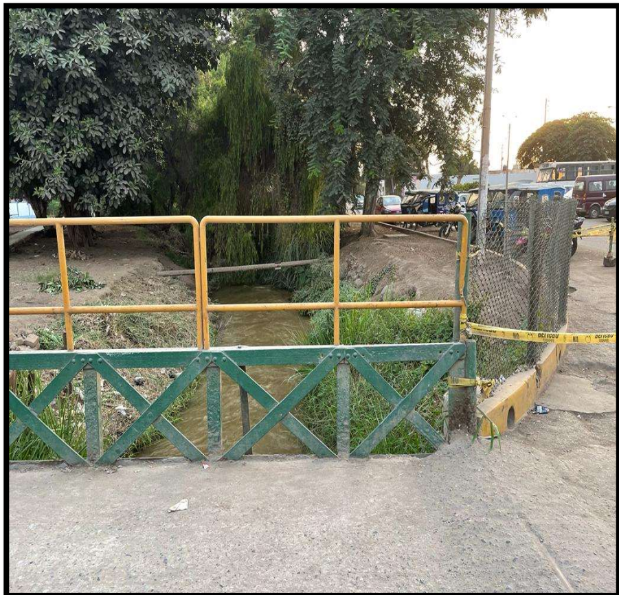
Fotografía 04: Vista desde puente existente
