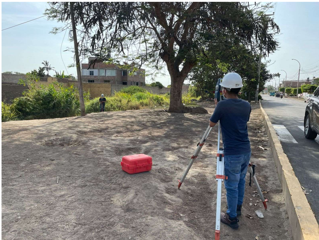
Fotografía 08: Levantamiento Topográfico del Canal.
