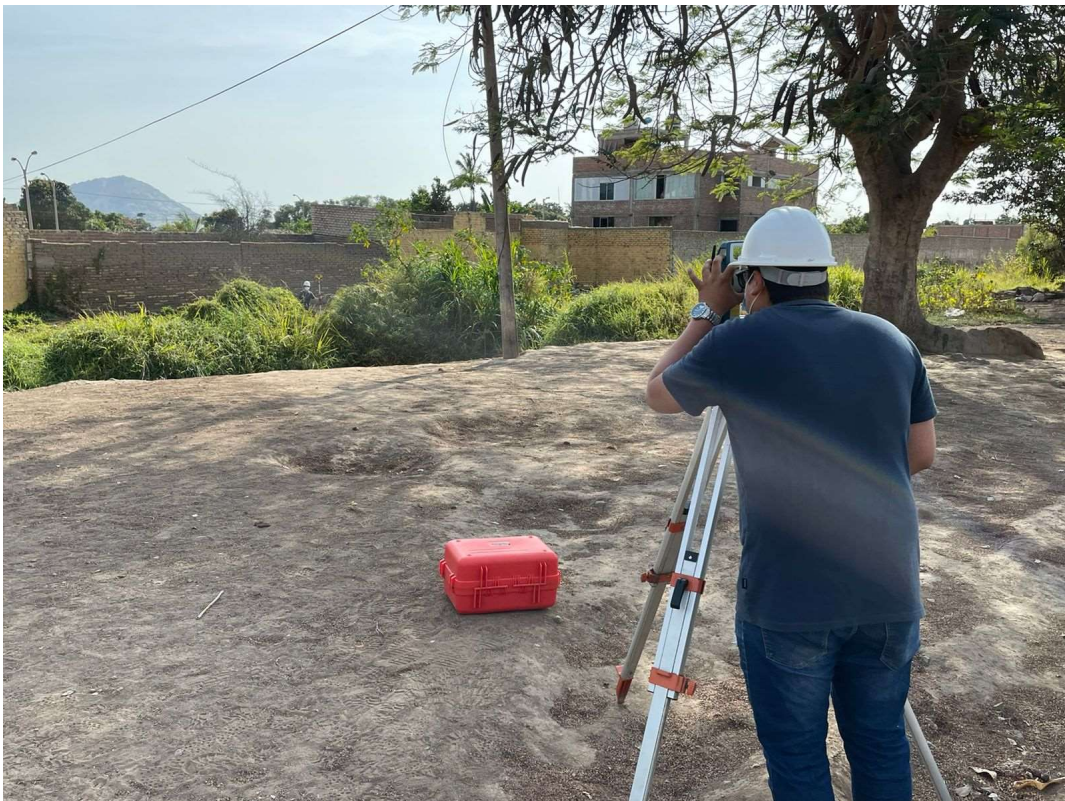
Fotografía 06: Levantamiento Topográfico del Canal.
