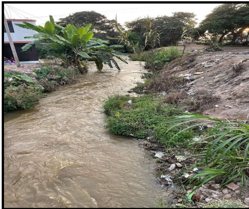
Fotografía 02: Canal aguas abajo
