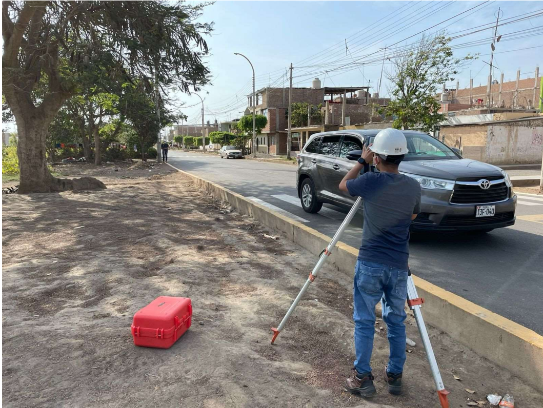
Fotografía 07: Levantamiento Topográfico de Sardinel existente.
