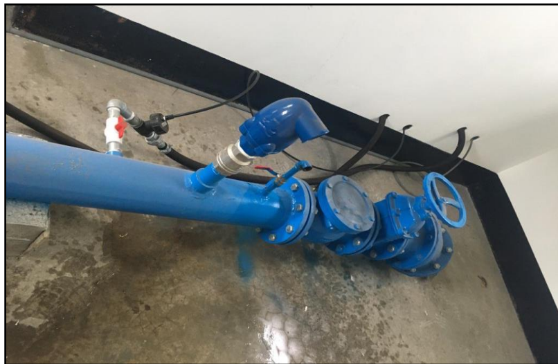
Figura 22. Pozo Arboleda I
