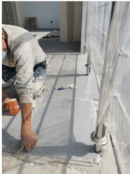
Colocación del porcelanato
