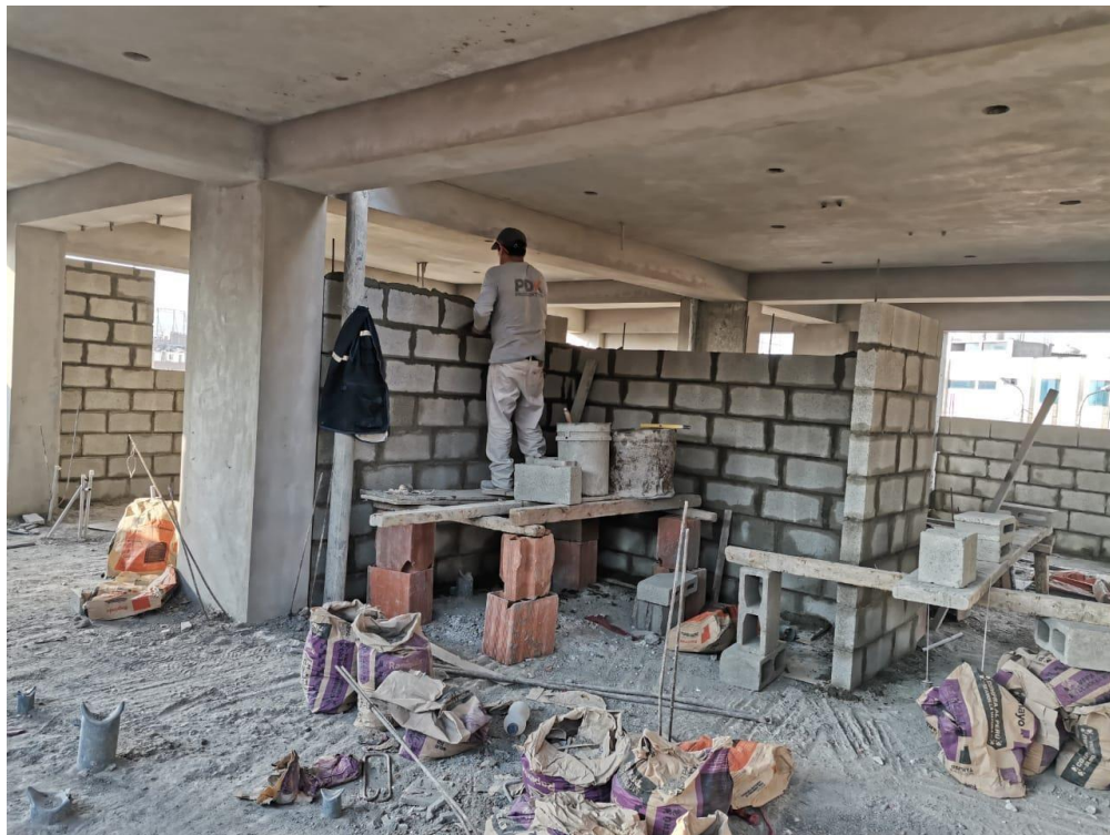
Colocación de mezcla
