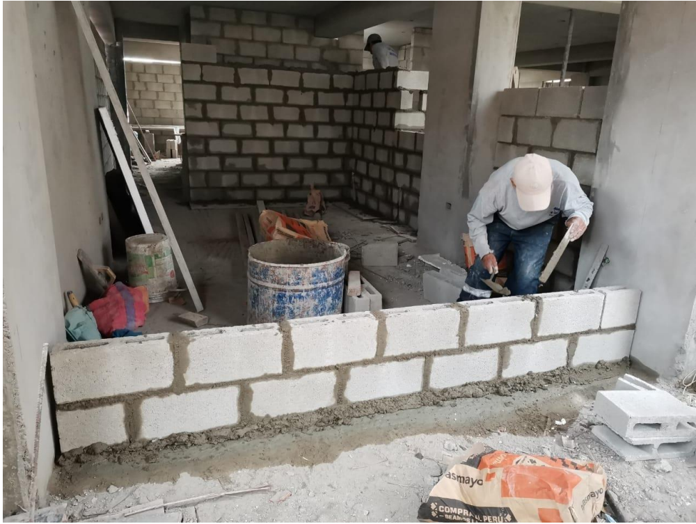
Colocación de mezcla
