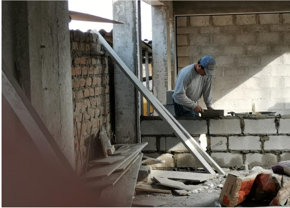
Colocación de mezcla
