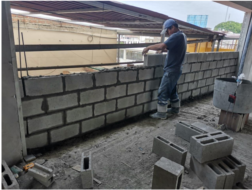
Colocación de bloques
