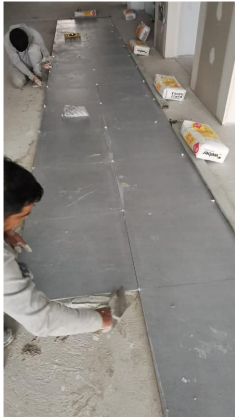
Aplicación de la mezcla
