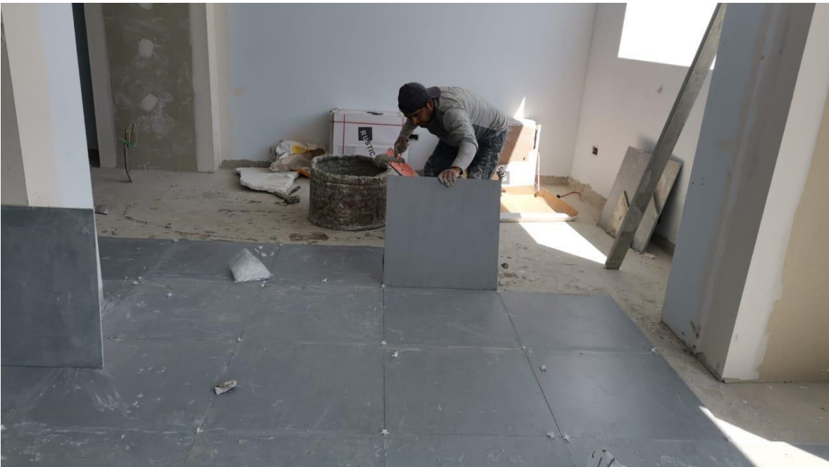
Aplicación de mezcla y colocación del porcelanato
