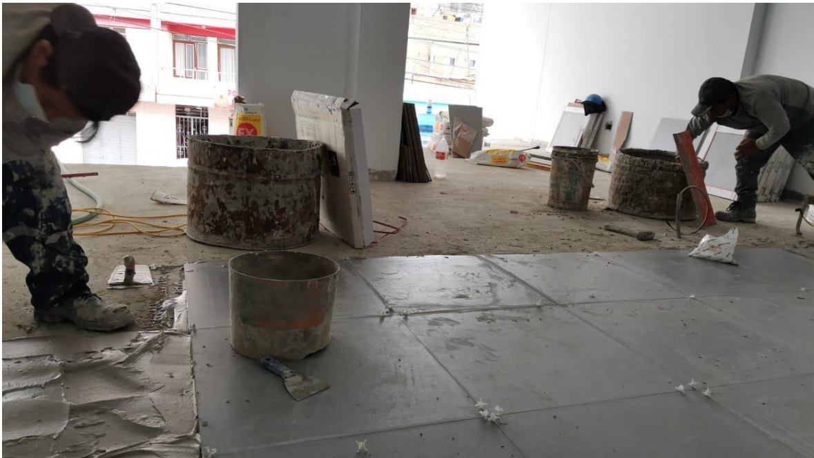
Aplicación de la mezcla
