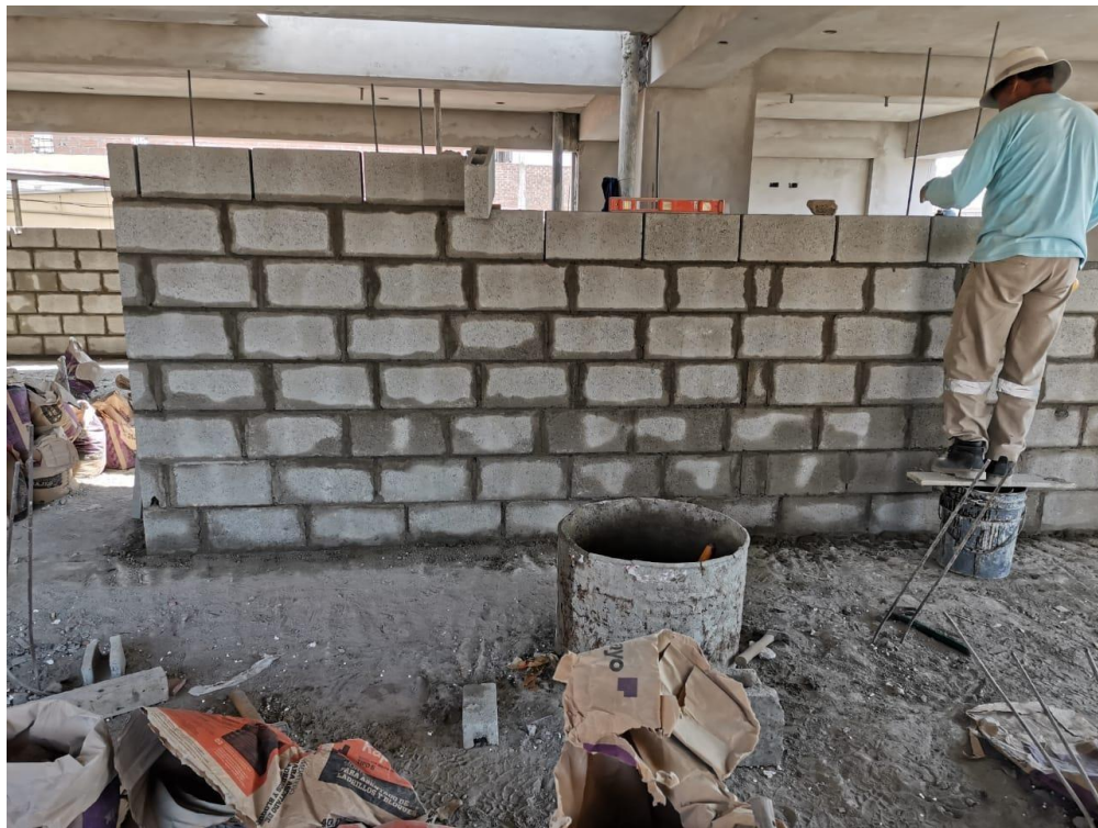
Verificación de nivel
