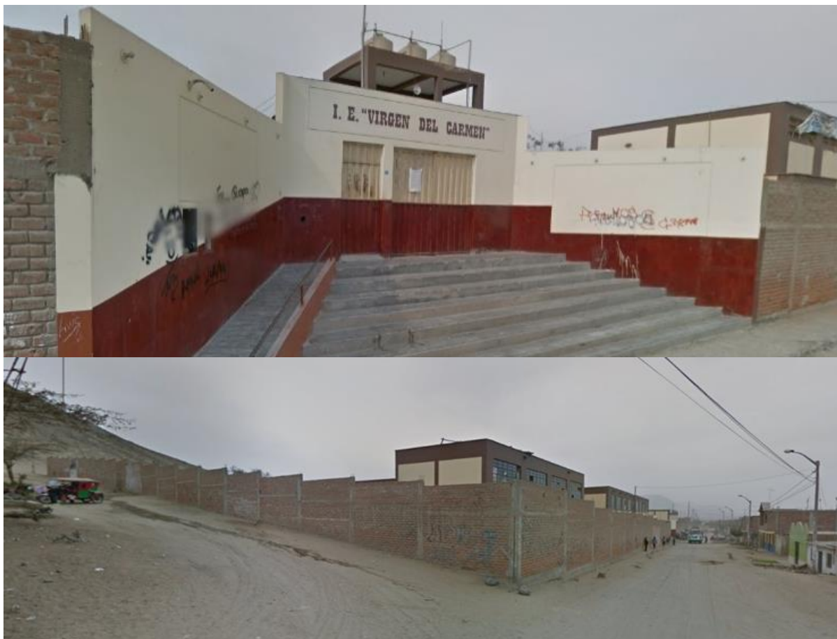
FOTOGRAFÍA N°01: Zona de ingreso y Cerco perimétrico a la I.E. "Virgen del Carmen"
