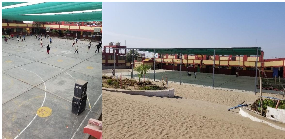
FOTOGRAFÍA N°08: Losas Multiusos de Nivel Primaria y Secundario.
