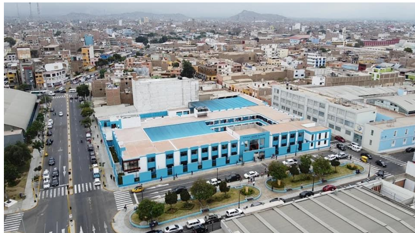
Fotografía N° 13 Vista general de la obra ejecutada en la I.E. N° 81011 Antonio Raimondi entorno al contexto
