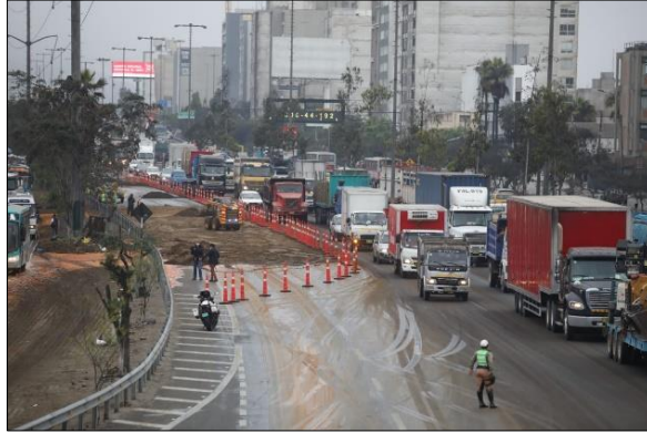
Figura 14: Vía con Obra de Intervención Fuente: Diario la republica
