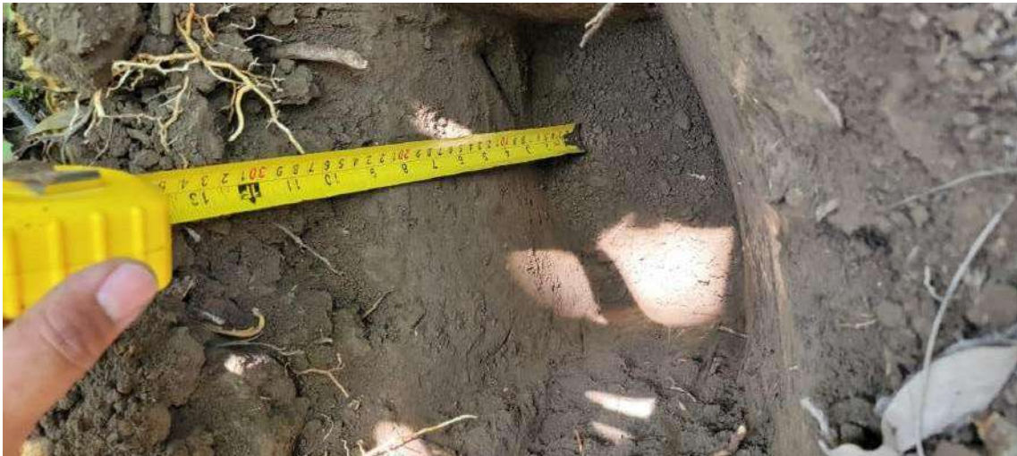
Ilustración 37: Profundidad de instalación
