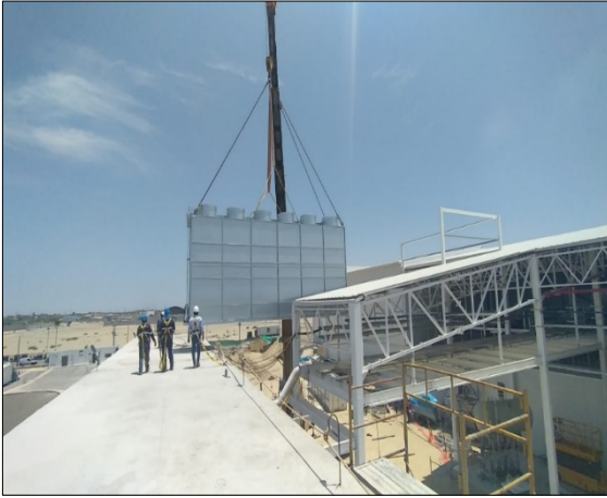
Evidencia 12 Montaje de condensador evaporativo
