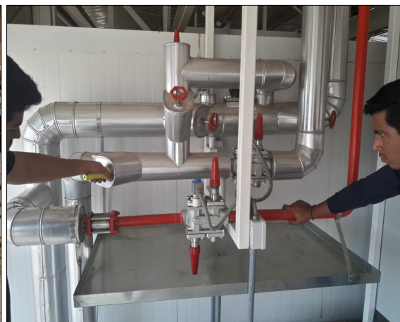
Evidencia 14 Presurizado del sistema con nitrógeno y aislamiento y encaquetado de los paquetes de válvulas.
