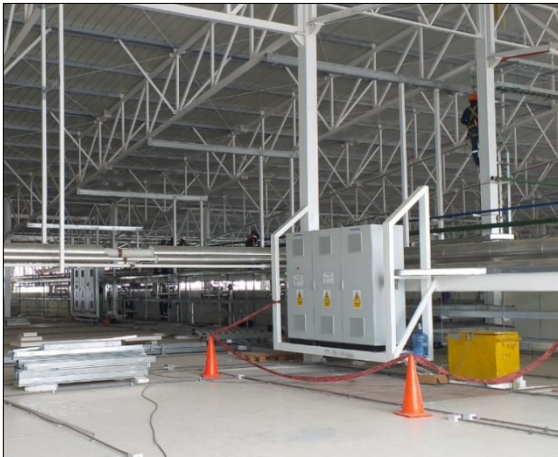
Evidencia 13 Izaje y montaje de tableros eléctricos.
