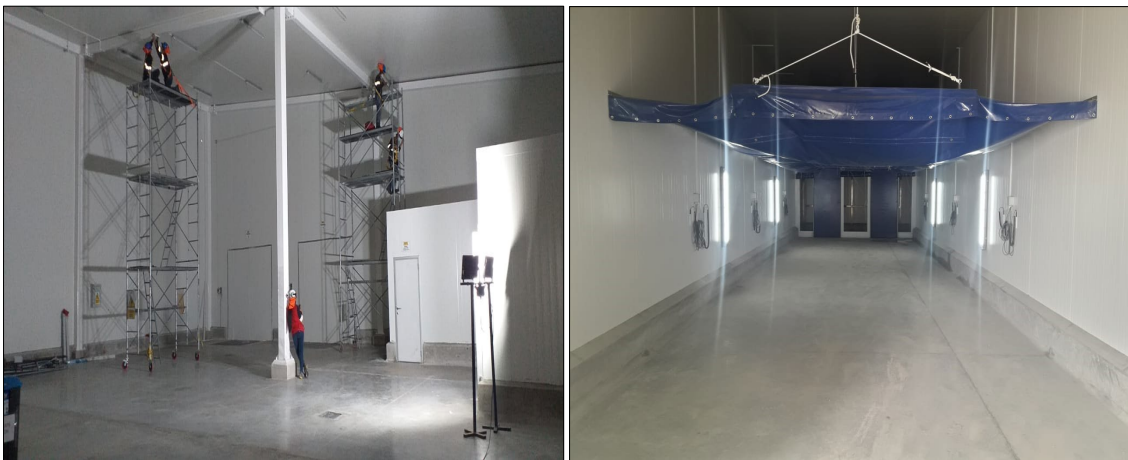
Evidencia 7 Acabados interiores en cámaras y túneles.
