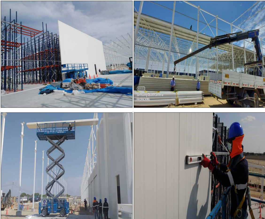
Evidencia 4 Montaje de paneles de pared y techo - Verificación del alineamiento.
