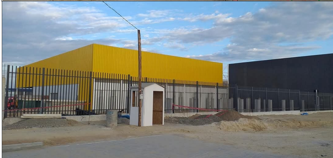
Evidencia 18 Fotos finales de la planta en funcionamiento.
