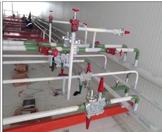
Evidencia 10 Armado de troncales, seccionamiento de líneas y armado de paquete de válvulas.
