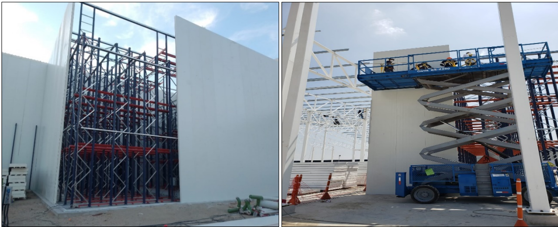
Evidencia 6 Verificación de pandeo de panel y montaje de cerramiento de cámaras.
