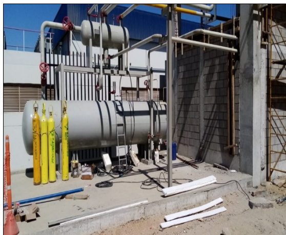
Evidencia 14 Presurizado del sistema con nitrógeno y aislamiento y encaquetado de los paquetes de válvulas.
