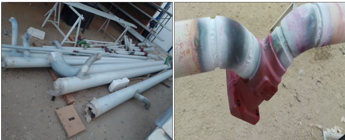
Evidencia 9 Armado de troncales, soldado de válvulas de seccionamiento y pruebas de tintes de penetración.
