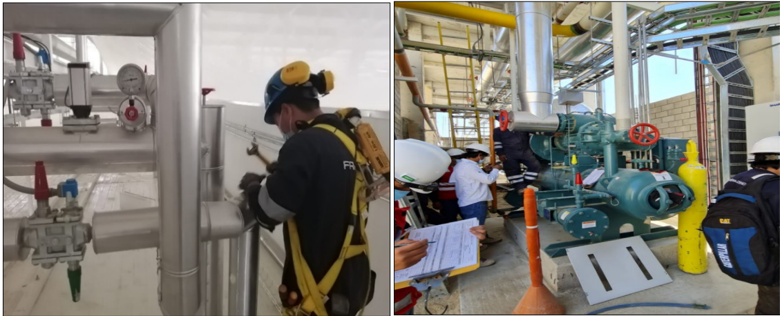
Evidencia 15 Regulación de válvulas y encendido del compresor.
