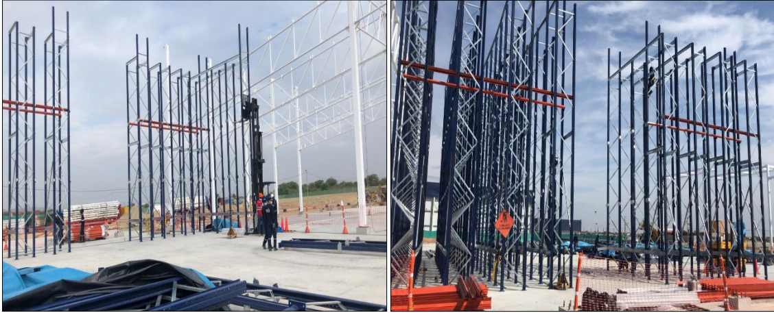
Evidencia 1 Armado de marcos y arriostras
