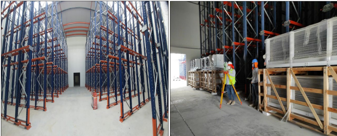
Evidencia 2 Armado de racks y liberación topográfica del alineamiento vertical y horizontal.
