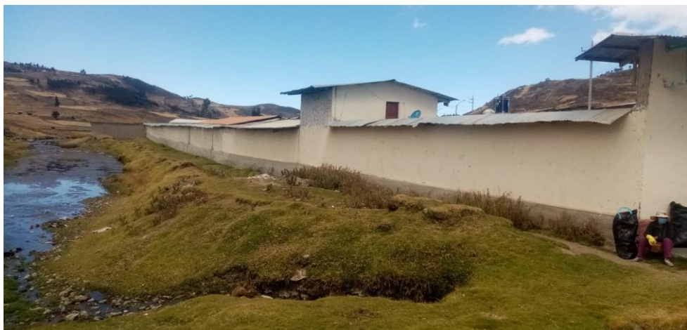
Ilustración 21: Fotografía del estado actual del colegio
