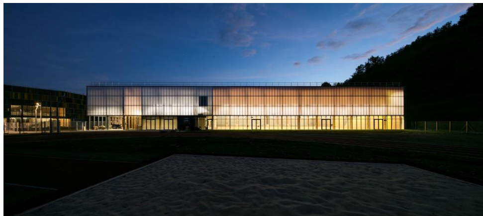
Ilustración 58: Vista exterior del comedor
