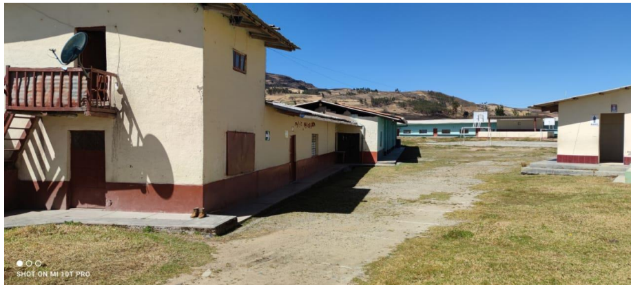
Ilustración 26: Fotografía del estado actual del colegio
