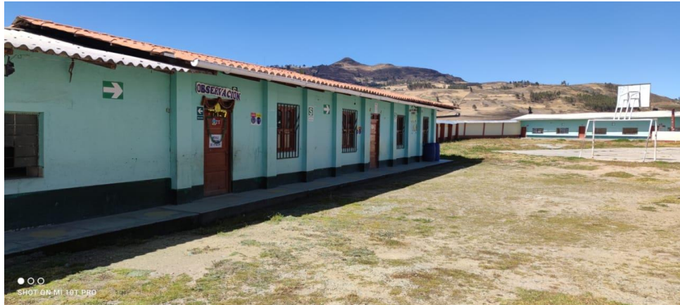
Ilustración 19: Fotografía del estado actual del colegio
