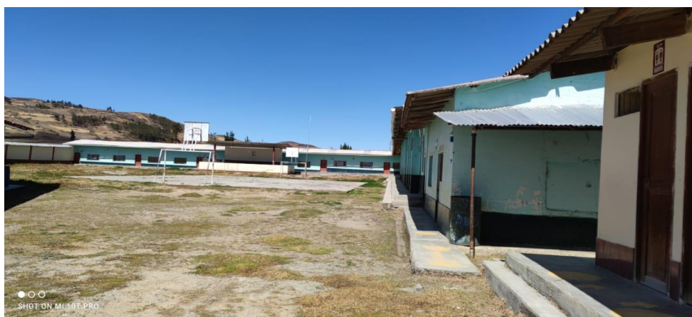
Ilustración 24: Fotografía del estado actual del colegio
