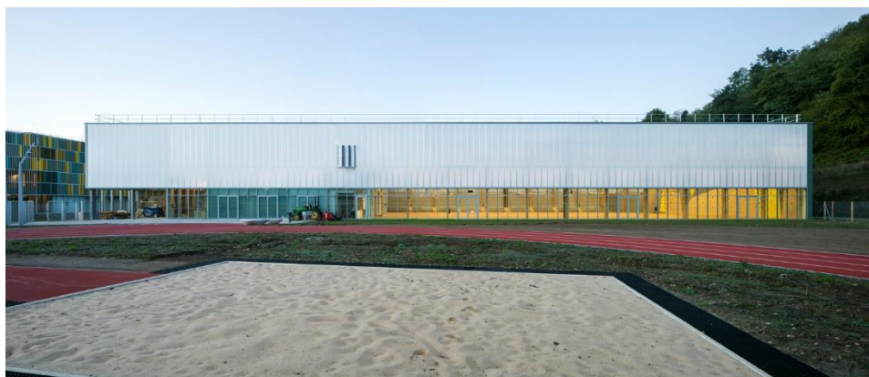
Ilustración 54: Vista Fachada interna
