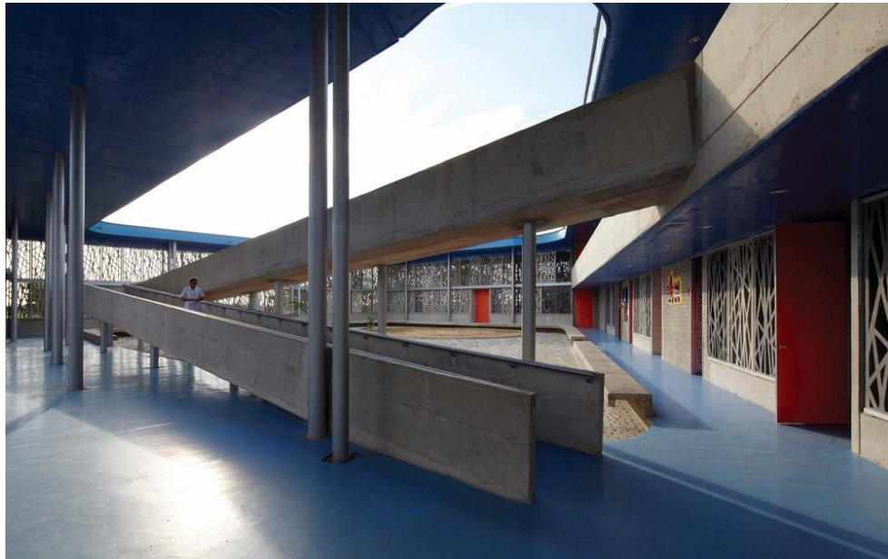
Ilustración 53: Vista Interior Rampas de acceso
