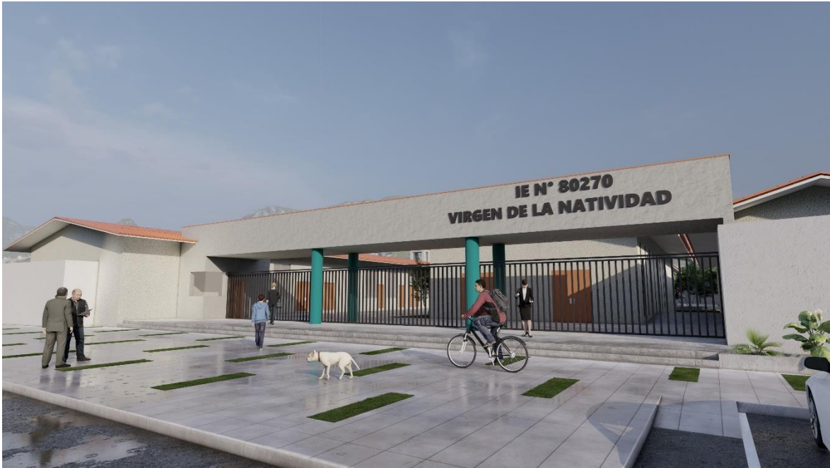
ILUSTRACIÓN 29: VISTA INGRESO PRINCIPAL
