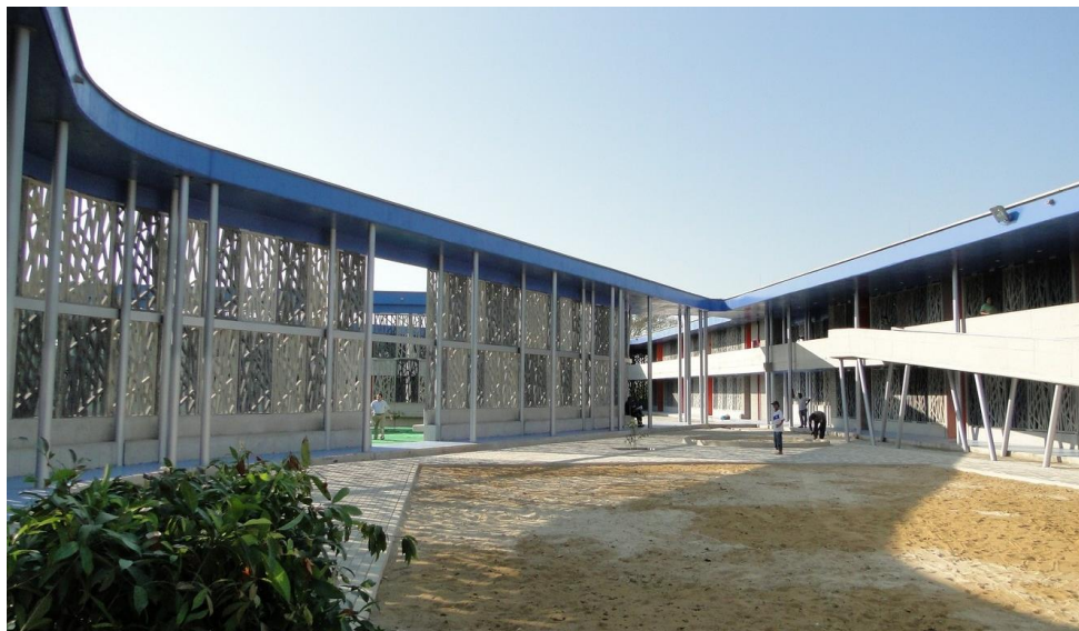
Ilustración 52: Vista Espacios internos Colegio Flor del Campo
