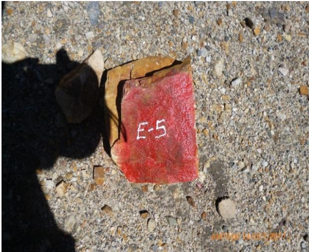
Foto N°05: Señalización de punto de la estación E-4
