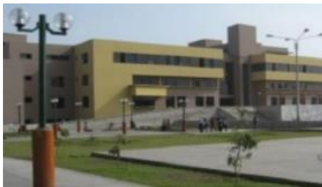
Imagen N° 09: Fachada del Palacio Municipal
