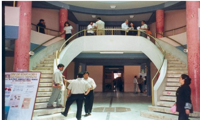
Imagen N° 14: Vista del 1er. Piso del Palacio Municipal
