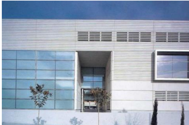
Imagen N° 08: Vista de fachada opuesto al ingreso principal
