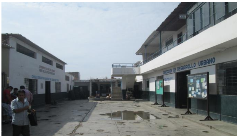
Imagen N° 20: Vista del Patio Interior del Anexo I
