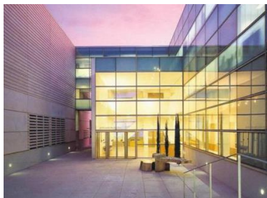
Imagen N° 07: Vista de plaza interior
