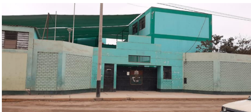
Imagen N°13. Fachada principal de la Institución Educativa Virú.
