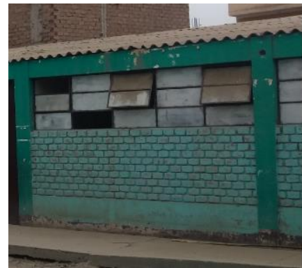
Imagen N°15. Fachada posterior de las aulas de inicial
