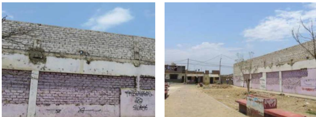
Imagen 6 y 7: Vista del cerco perimétrico que limita con la calle de la Torre
