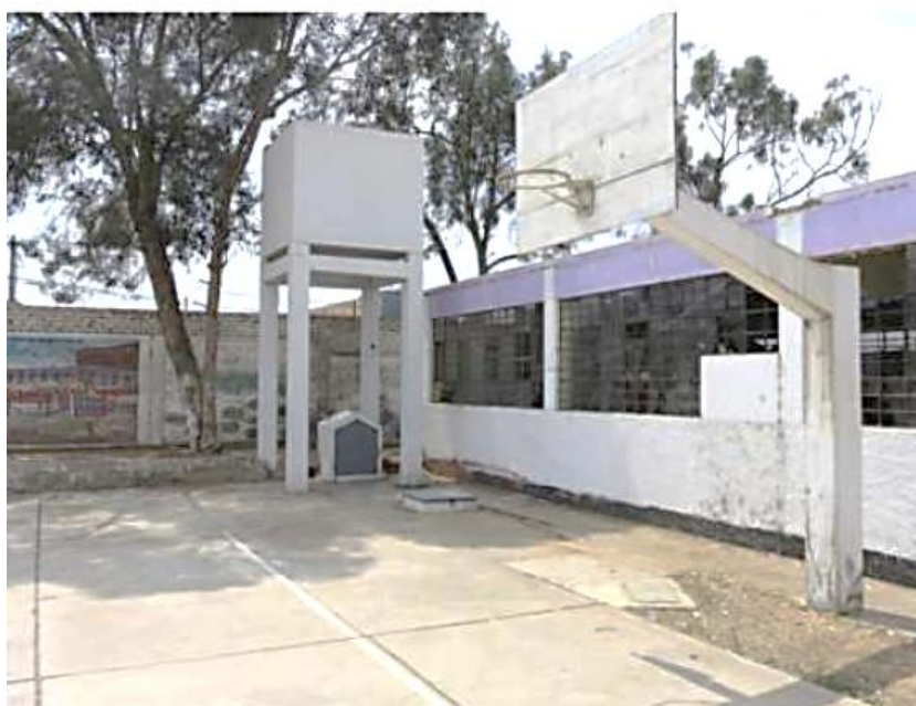
Imagen 12: Vista del reservorio y losa deportiva nivel Secundario
