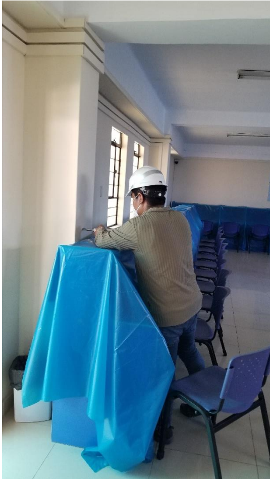
FIGURA 33: Ensayo esclerométrico en columnas del bloque "A" en el 2do piso.
