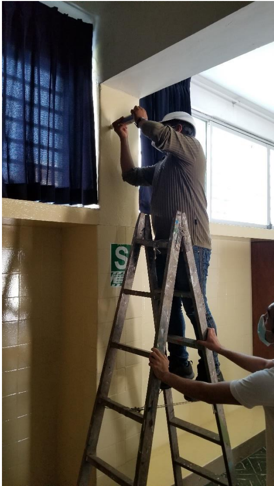
FIGURA 31: Ensayo esclerométrico en columnas del bloque "B" en el 1er piso.
