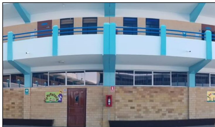
FIGURA 07: Junta Sísmica presente en la edificación.
