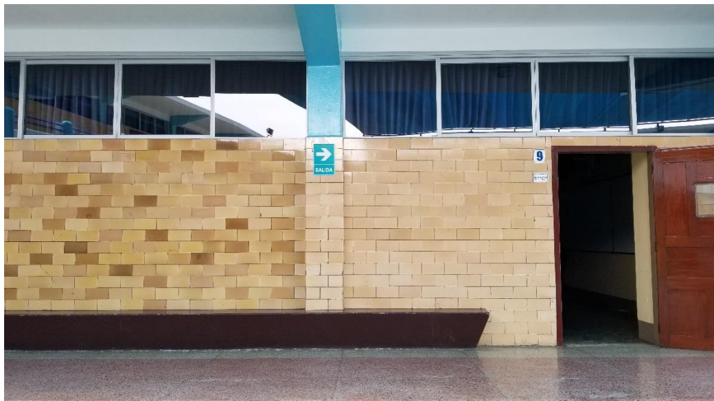
FIGURA 25: Muros externos en buena condición sin lesiones visibles.
