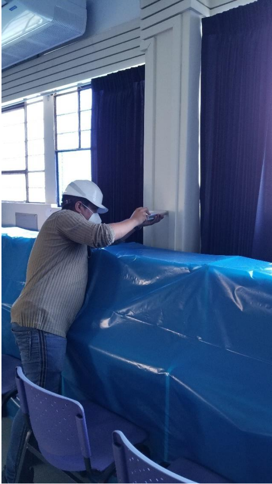
FIGURA 35: Ensayo esclerométrico en columnas del bloque “B” en el 2do piso.
