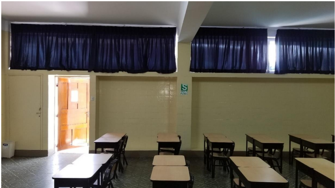
FIGURA 12: Interior del aula 7 del bloque “A”, presenta mampostería uniforme y en un buen estado.
