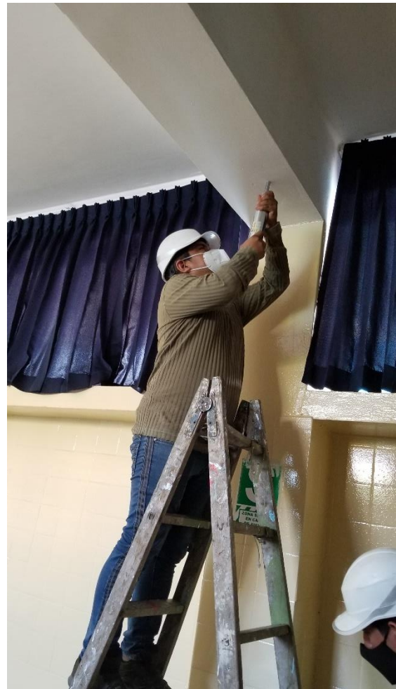
FIGURA 32: Ensayo esclerométrico en vigas del bloque "B" en el 1er piso.
