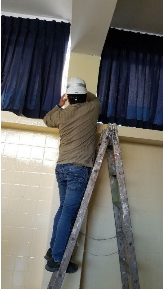
FIGURA 29: Ensayo esclerométrico en columnas del bloque "A" en el 1er piso.
