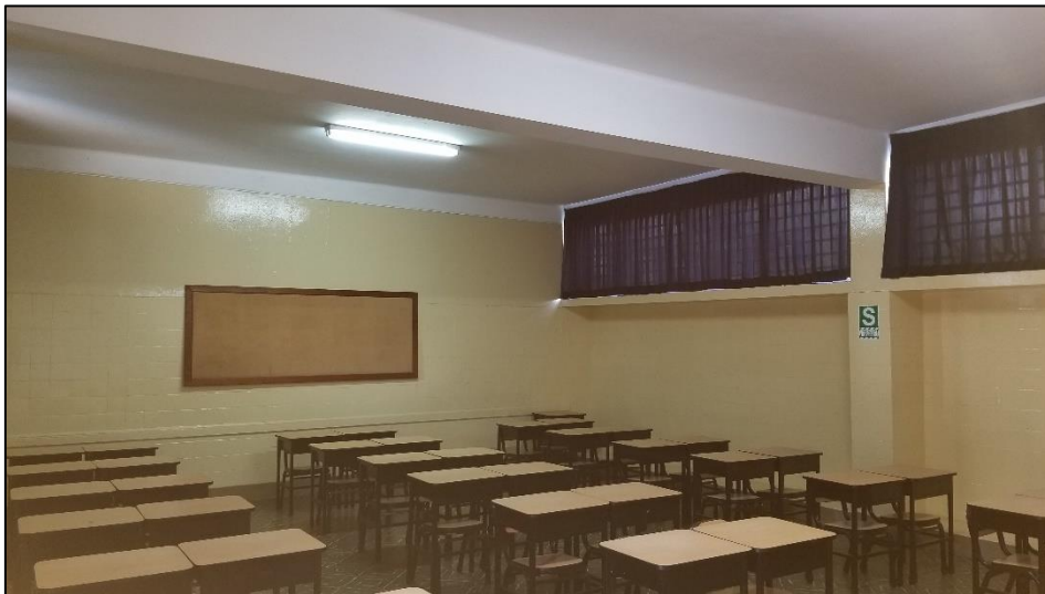
FIGURA 20: Altura regular en cada uno de los muros del Bloque "A".
