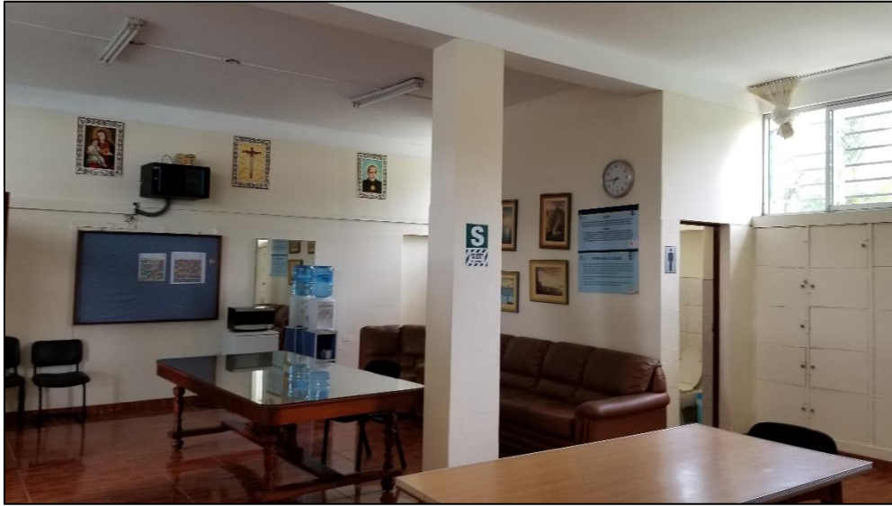
FIGURA 21: Altura regular en cada uno de los muros del Bloque “B”.
