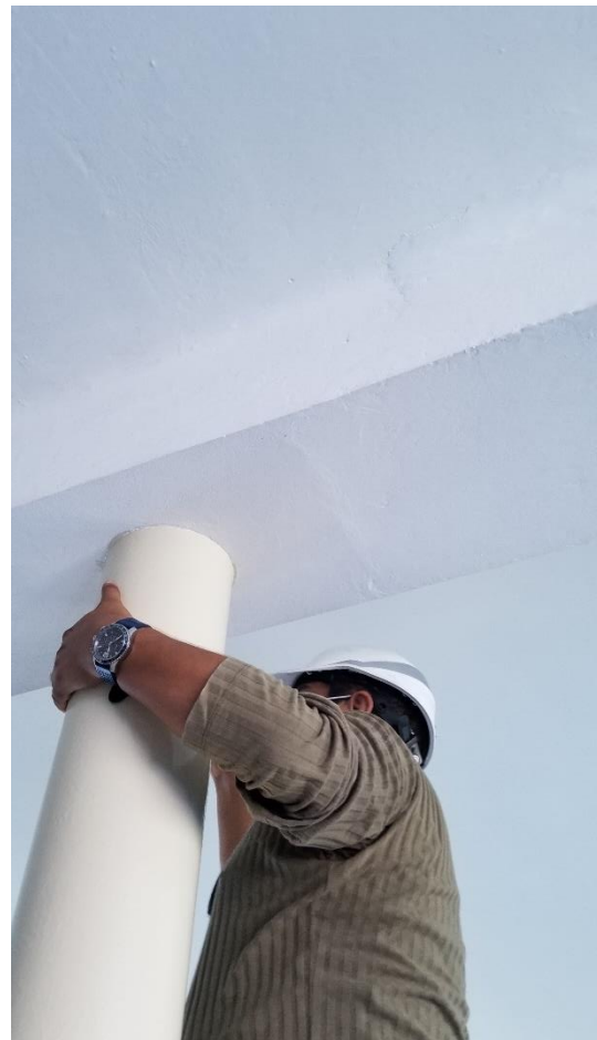
FIGURA 36: Ensayo esclerométrico en vigas del bloque “B” en el 2do piso.
