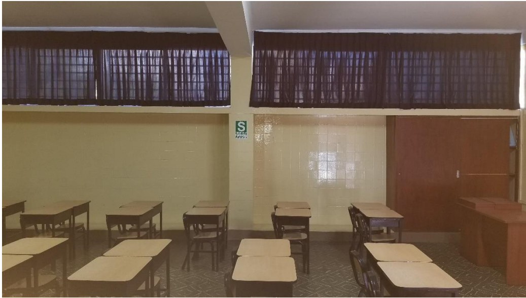
FIGURA 26: Muros internos en buena condición sin lesiones visibles.
