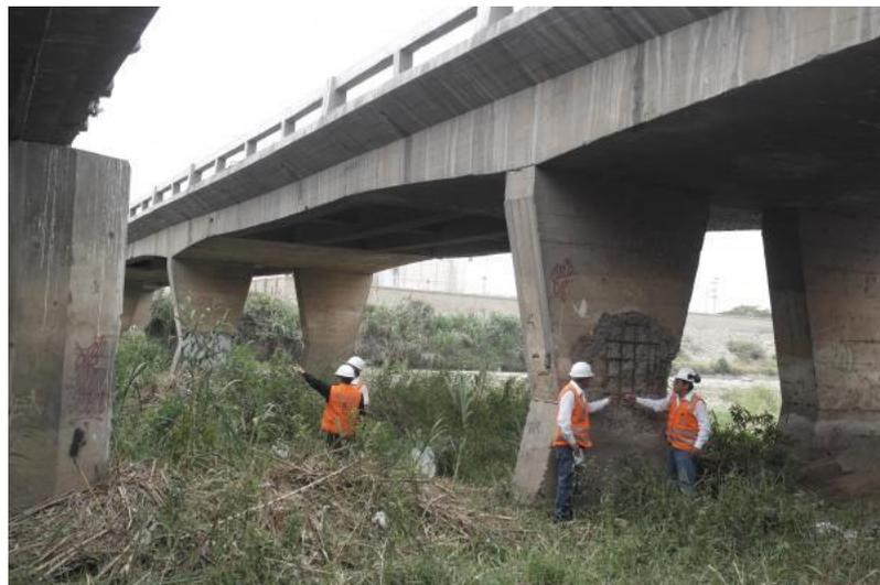
**Fotografía 3: Vista del Deterioro de Pilares del Puente Moche**
