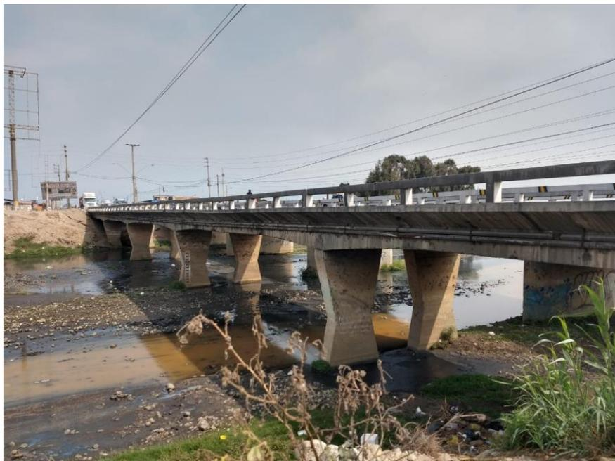
**Fotografía 2 . “Vista del Puente sobre el Rio Moche, el cual necesita un nuevo diseño (altura y luz), dado que la solución al drenaje de las Quebradas San Ildefonso y San Carlos, se incrementará el volumen del Rio Moche”. “Fuente: Elaboración propia de Tesistas”**
