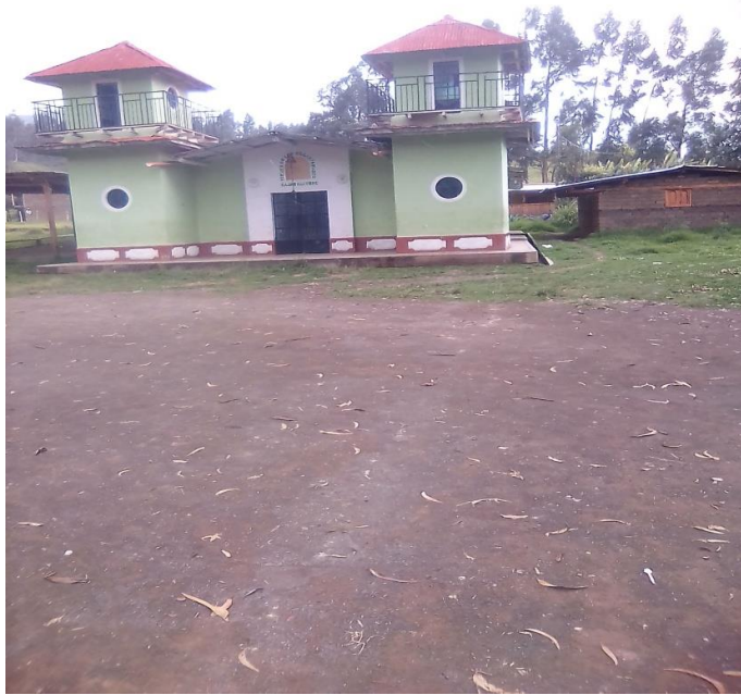
FOTO 11.LEVANTAMIENTO EN VIVIENDAS, LOCALES IGLESIAS ETC.
