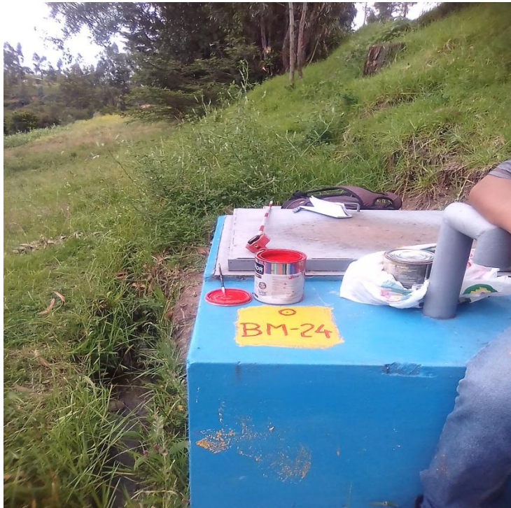
FOTO 14.BMS.COLOCADOS EN EXTRUCCTURA EXISTENTE
