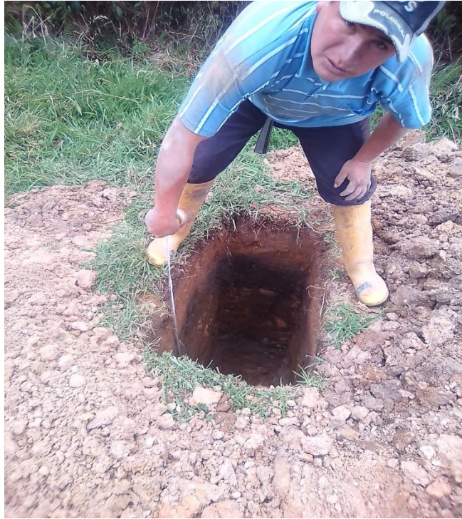
FOTO 19 EXCAVACION DE CALICATA
