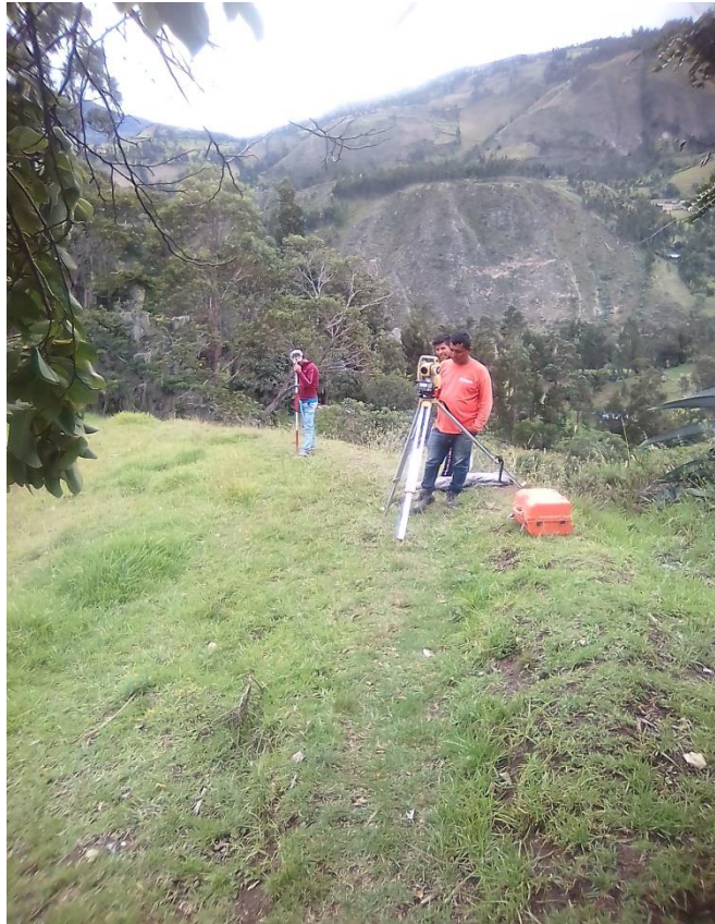
FOTO 12.LEVANTAMIENTO EN LINEA DESTRIPLICION EN RAMALES
