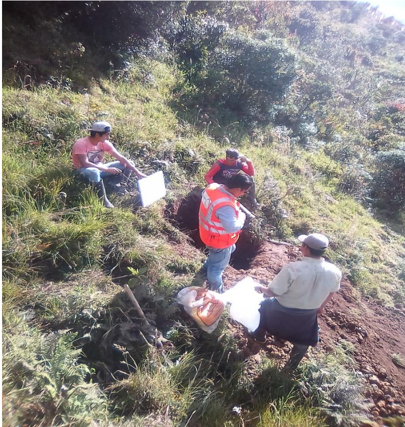
FOTO 05.-CAPTACION PROYECTADA N°1 Y CALICATA
