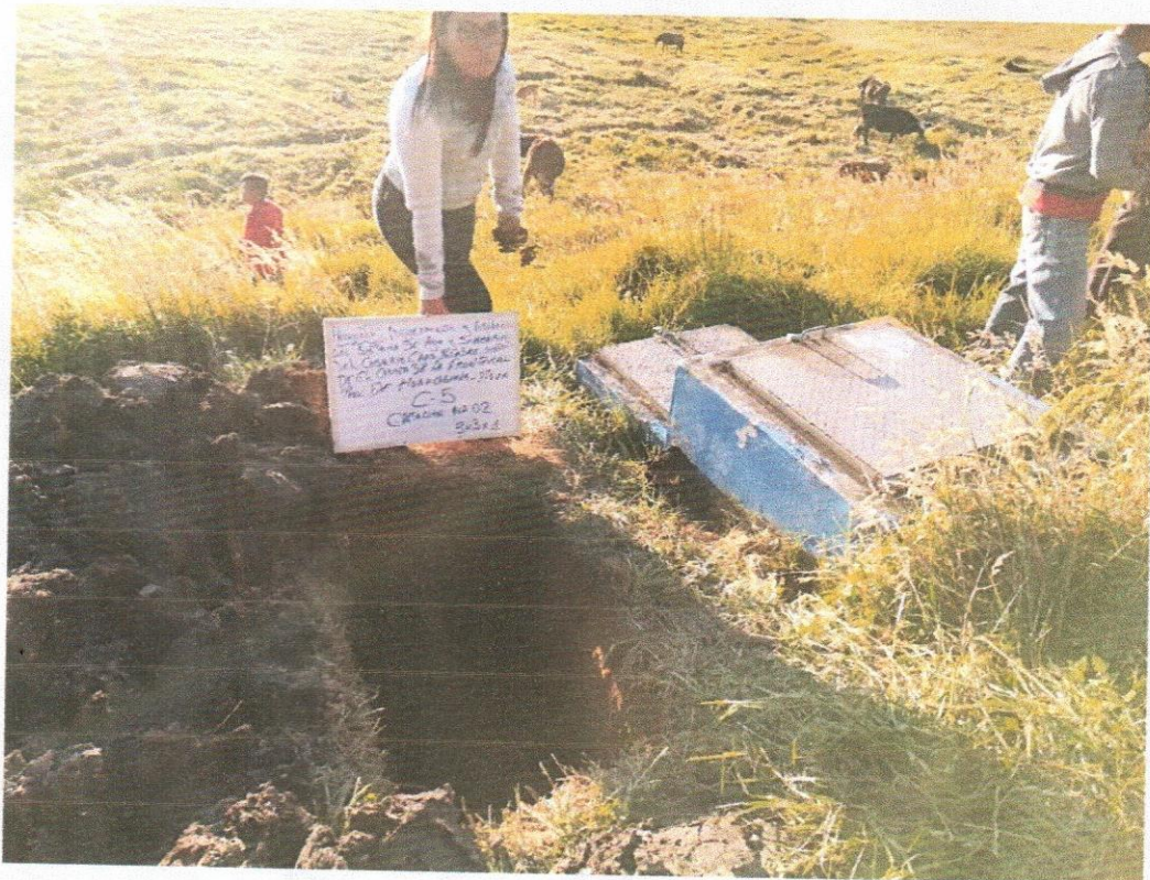
Perforación de la Calicata N° 05, ubicada en la CAPTACIÓN N° 02.
