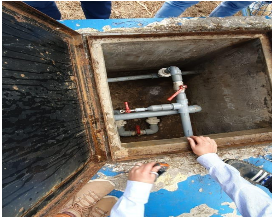
Fotografía 5 Caseta de válvula de reservorio
