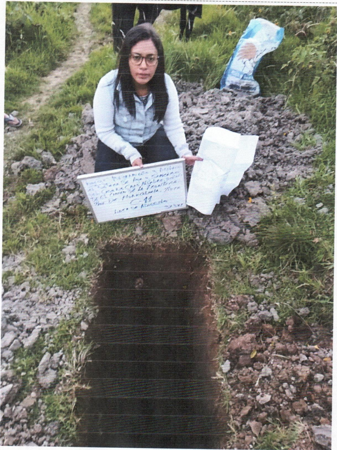
Perforación de la Calicata N° 11, ubicada en la LINEA DE ADUCCIÓN.
