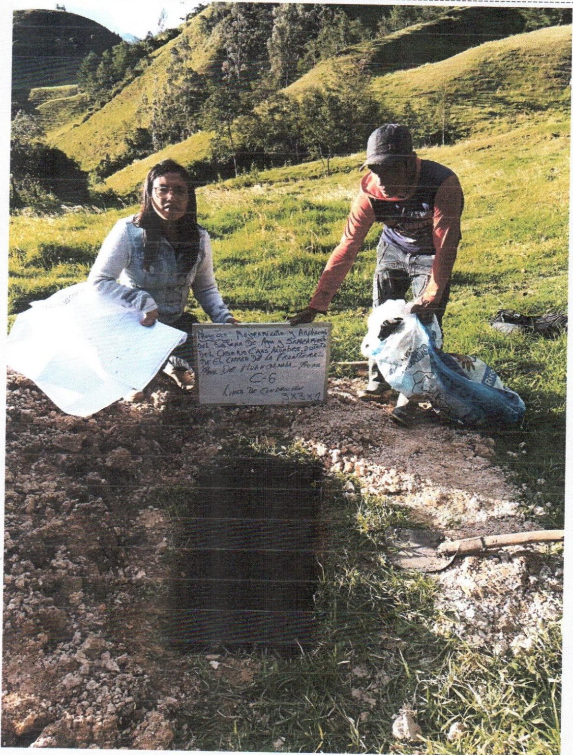
Perforación de la Calicata N° 06, ubicada en la LINEA DE CONDUCCIÓN.
