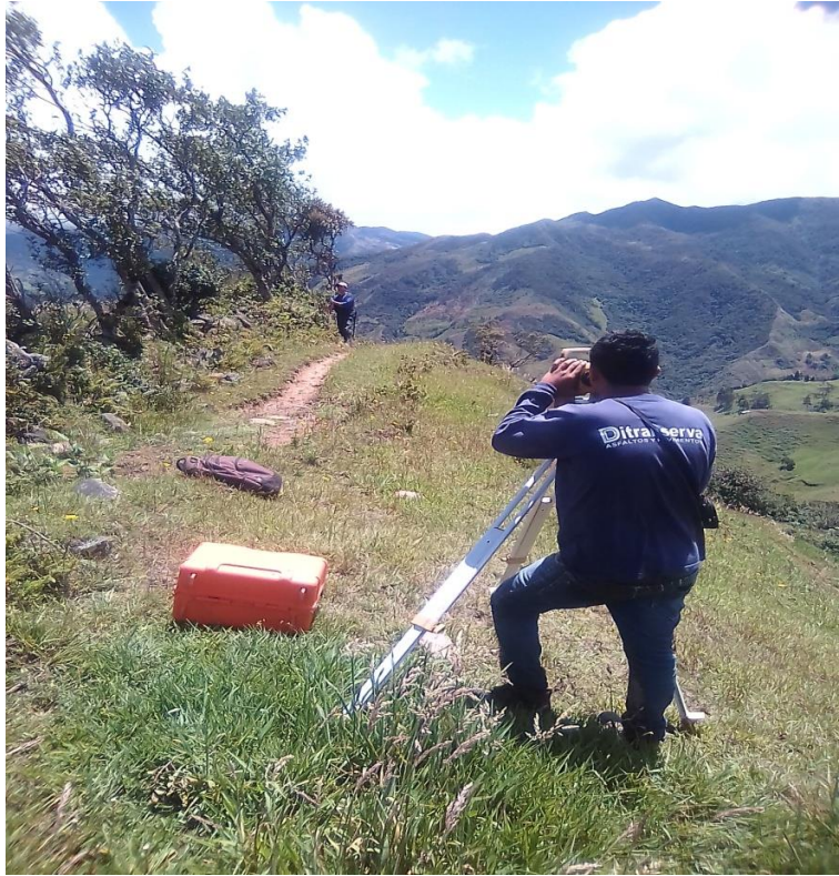
FOTO 07. CONTINUACION DE LINEA DE CONDUCCION
