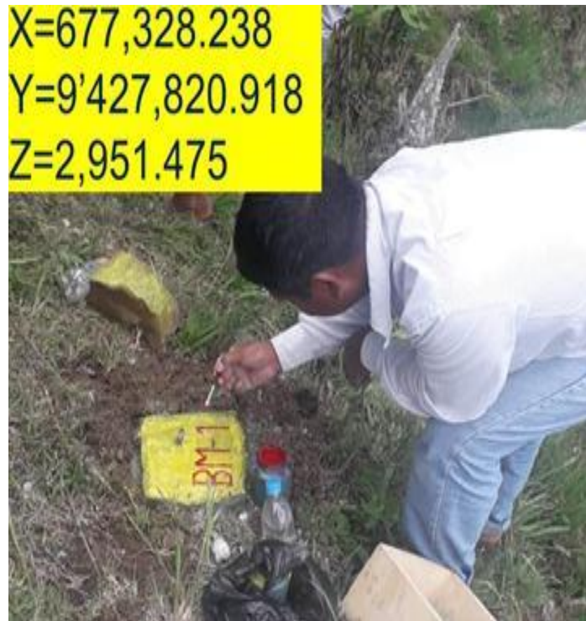
FOTO 23 MONUMENTACION DE BMS
