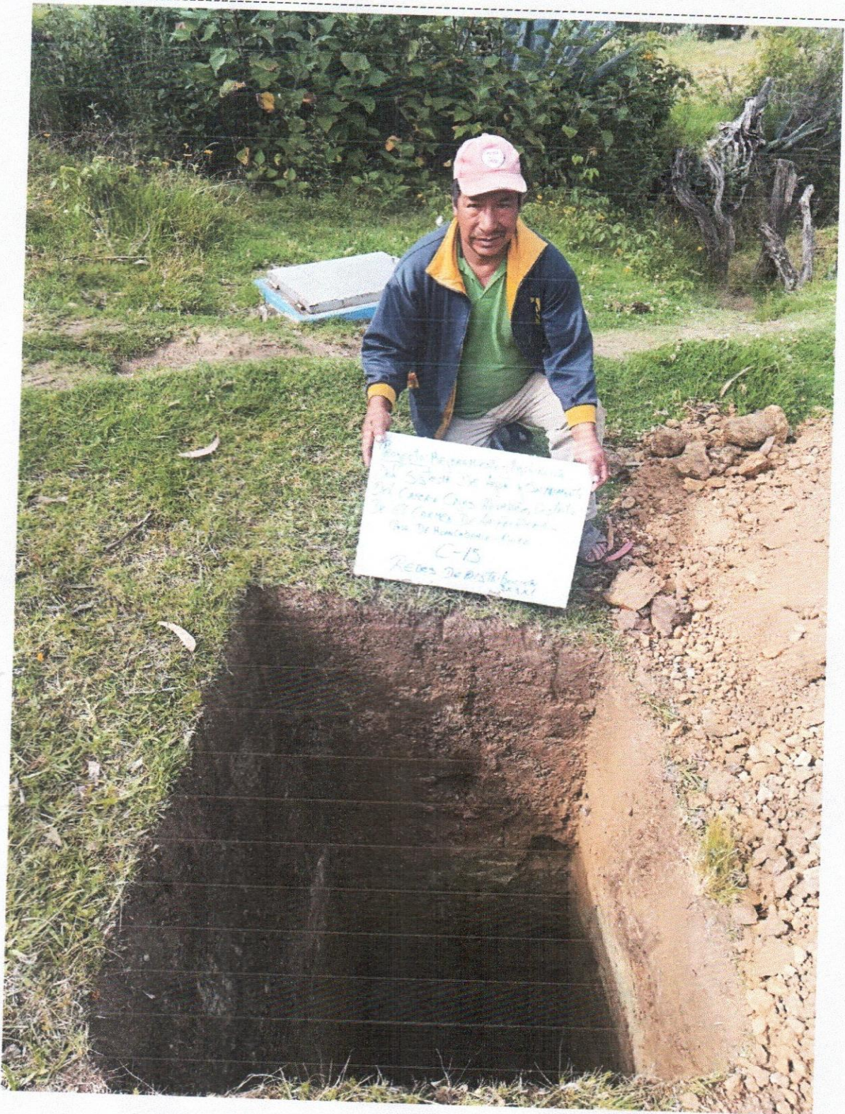
Perforación de la Calicata N° 15, ubicada en REDES DE DISTRIBUCIÓN.
