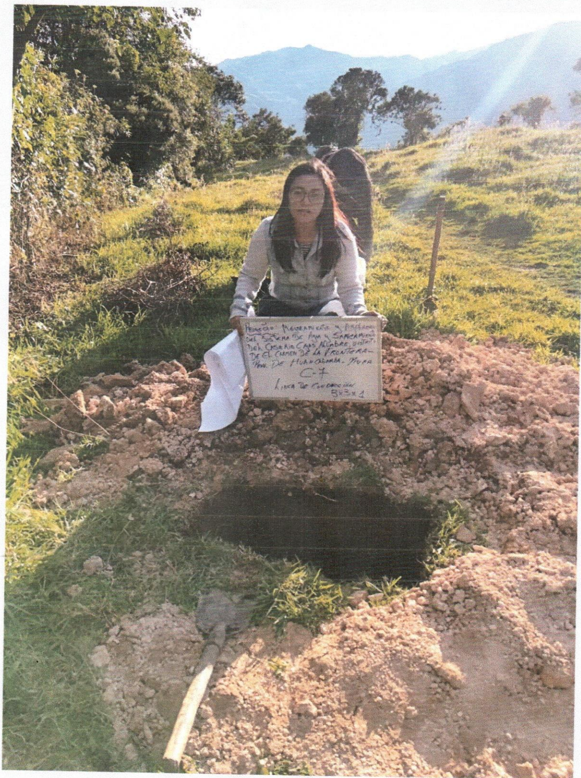
Perforación de la Calicata N° 07, ubicada en la LINEA DE CONDUCCIÓN.
