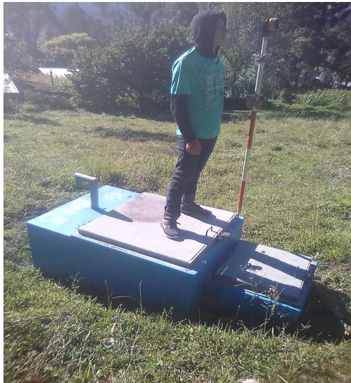
FOTO 08. CAMARAS ROMPE PRESION EN LINEA DE CONDUCCION
