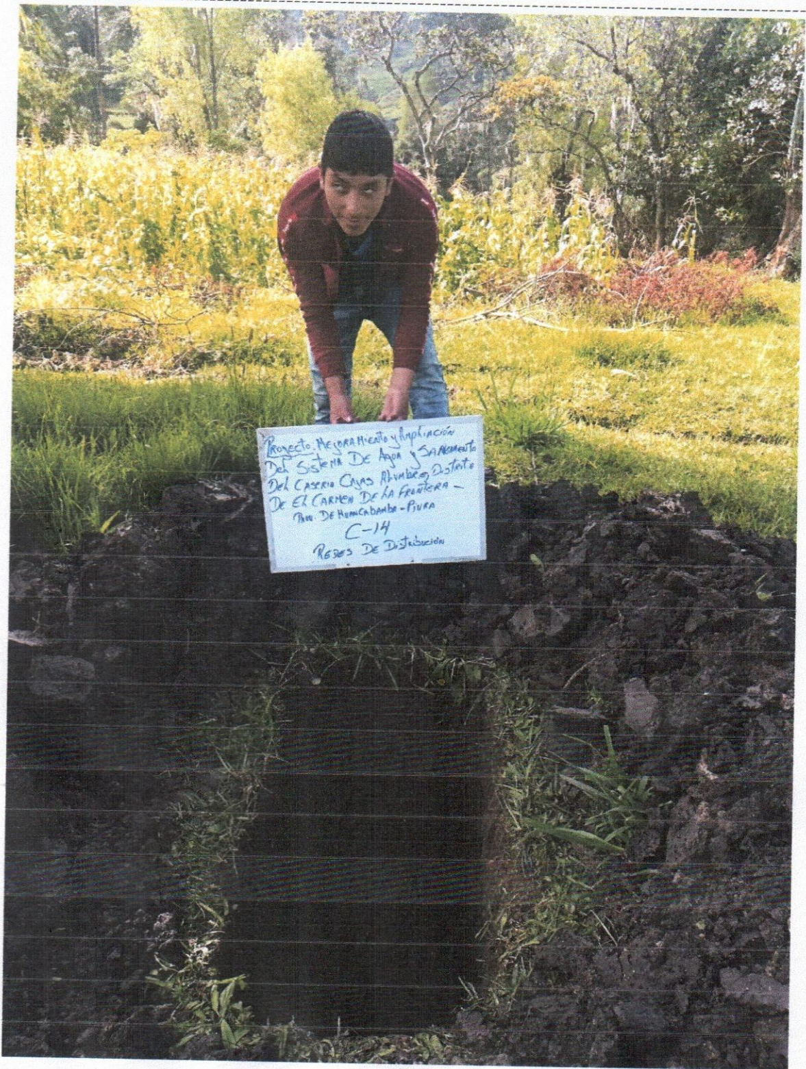
Perforación de la Calicata N° 14, ubicada en REDES DE DISTRIBUCIÓN.
