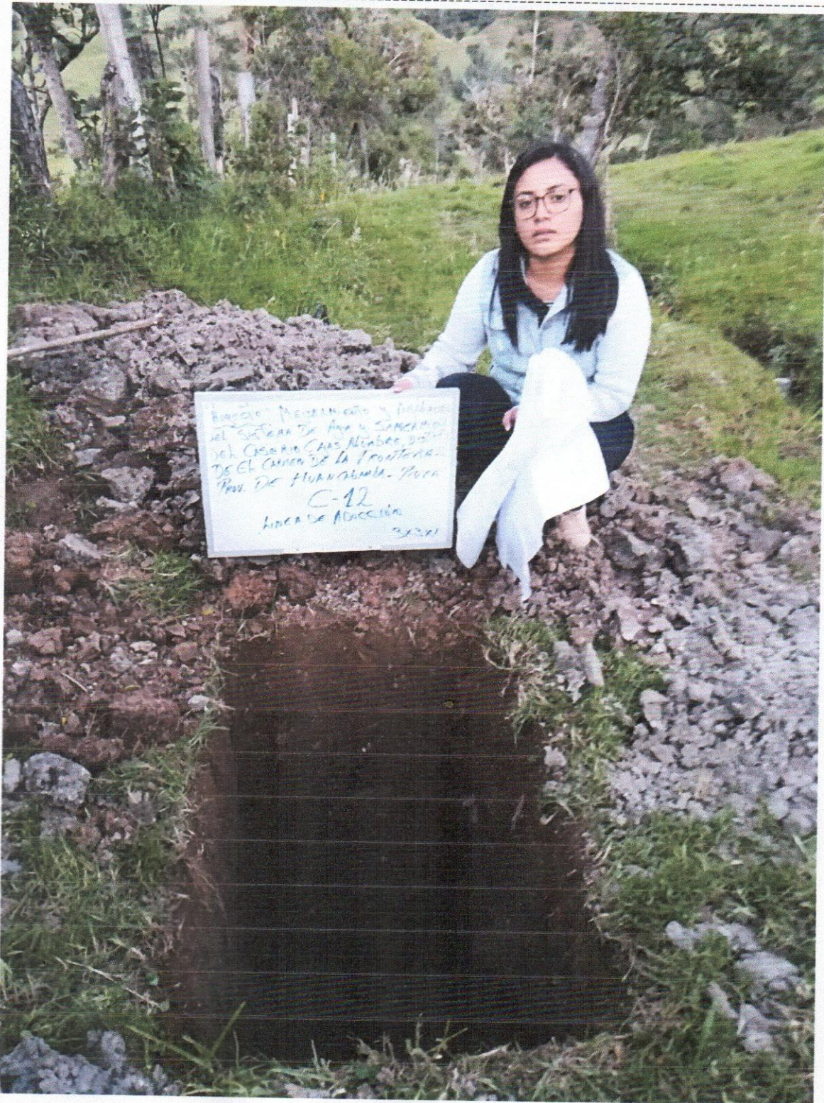
Perforación de la Calicata N° 12, ubicada en la LINEA DE ADUCCIÓN.
